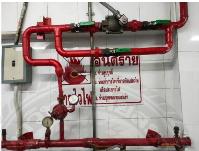
รูปที่ 4.2 การตรวจสอบระบบท่อแก๊ส
