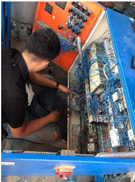
รูปที่ 4.6 แก้ไขระบบไฟฟ้า
