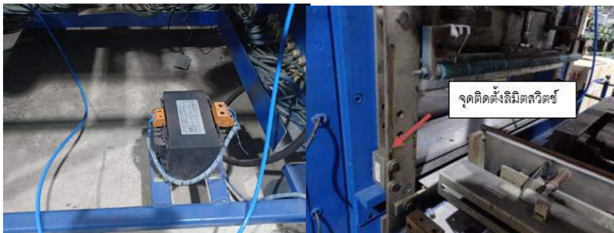
รูปที่ 4.11 จุดติดตั้งหม้อแปลงและลิมิตสวิตช์
