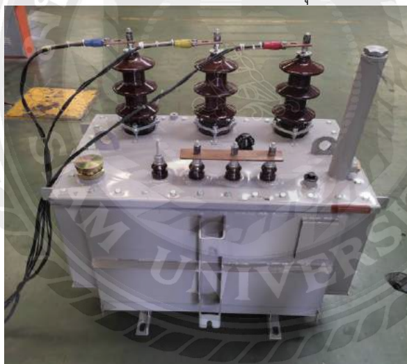
รูปที่ 4.40 นำ Busbar ทองแดงต่อเข้ากับ LV Terminal
