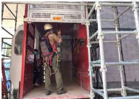
รูปที่ 2.18 ตรวจสอบลิฟต์ขนส่งชั่วคราว
