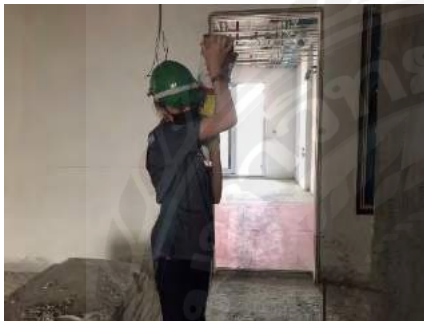
รูปที่ 2.12 การตรวจถังดับเพลิงประจำเดือน
