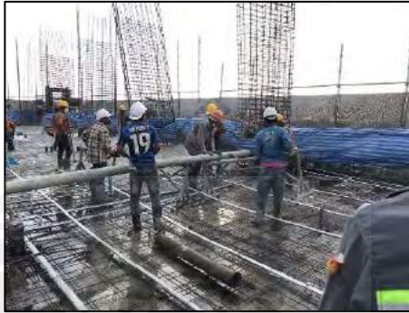
รูปที่ 2.3 การเทพื้นคอนกรีตแบบตารางสี่เหลี่ยม
