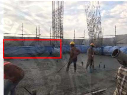
รูปที่ 2.27 กั้นพื้นที่ป้องกันปูนกระเด็นใส่บ้านข้างเคียง
