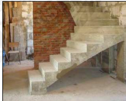
รูปที่ 2.7 บันไดคอนกรีตเสริมเหล็ก
