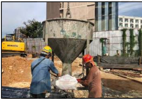
รูปที่ 2.26 ตรวจสอบอุปกรณ์เทคอนกรีต
