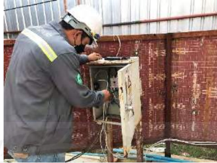
รูปที่ 2.20 ตรวจสอบตู้ไฟฟ้าและการต่อสายดิน
