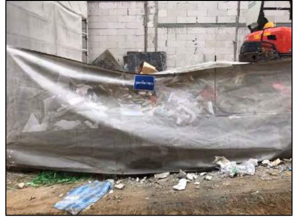
รูปที่ 4.7 มาตรการกำหนดบริเวณวางวัสดุที่ไม่ใช้งานแล้วและติดป้ายชัดเจน
