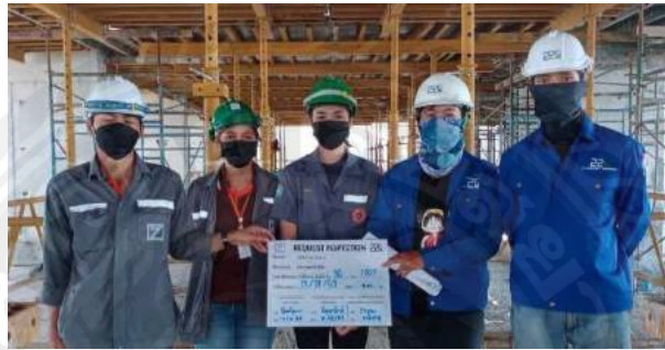
รูปที่ 2.23 ตรวจสอบ โครงสร้างนั่งร้านร่วมกับวิศวกร
