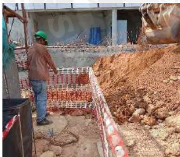
รูปที่ 2.21 การปิดล้อมบริเวณร่องลึก หลุมลึก
