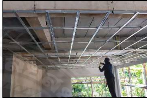
รูปที่ 2.4 การติดตั้งฝ้า
