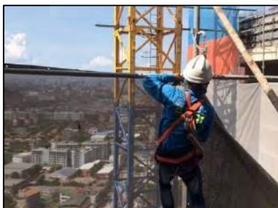
รูปที่ 2.14 การสวมใส่อุปกรณ์ ป้องกันการตกจากที่สูง
