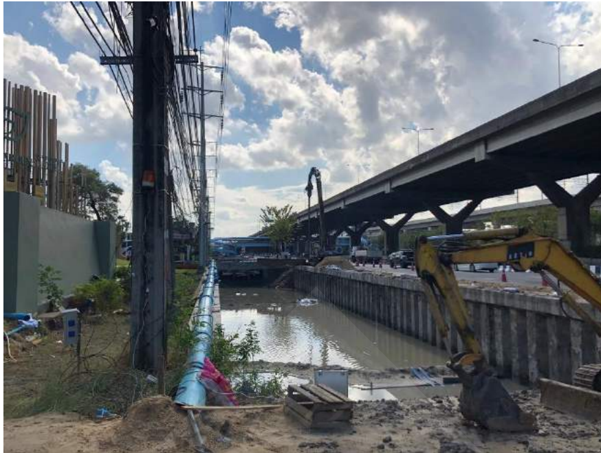
รูปที่ 4.2 สภาพบริเวณหน้างานของคูน้ำริมถนน
