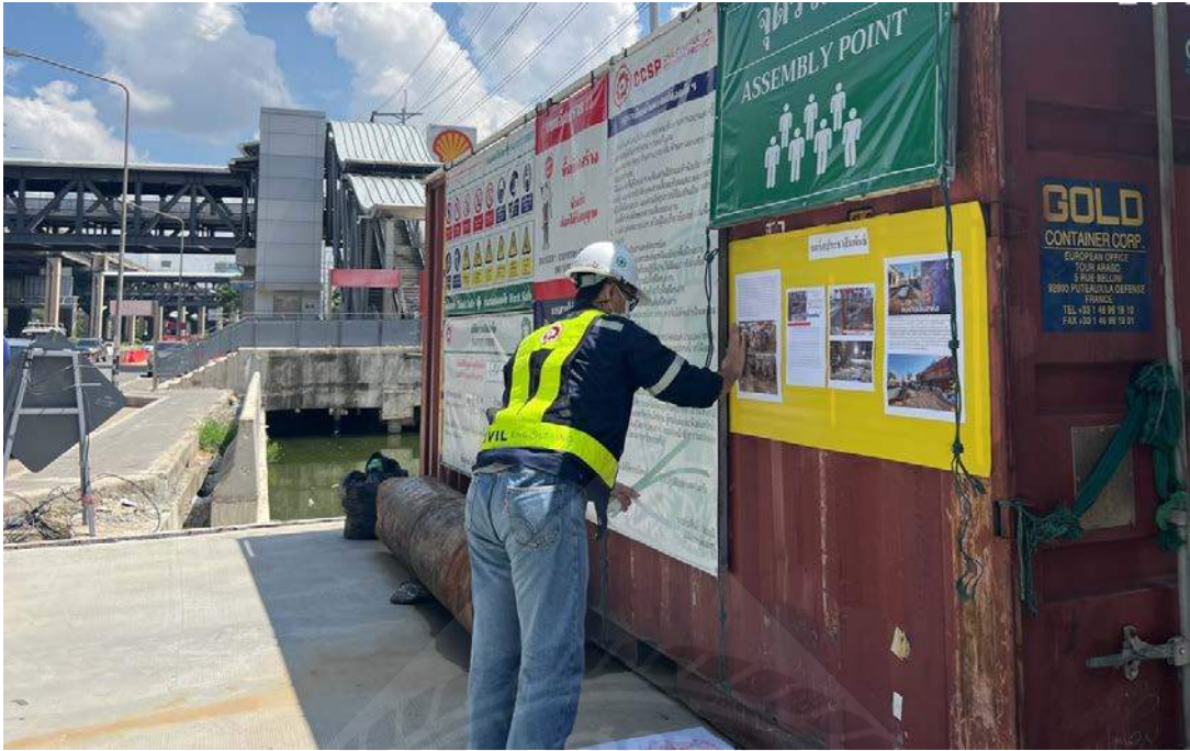
รูปการติดบอร์ดประชาสัมพันธ์ข่าวสารในด้านความปลอดภัย
