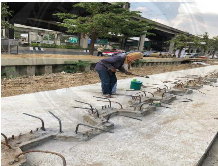
รูปที่ 4.3 สภาพของการทำงานของพนักงานกำลังตัดเหล็กเพื่อทำการผูกเหล็กและทำการเทคอน
