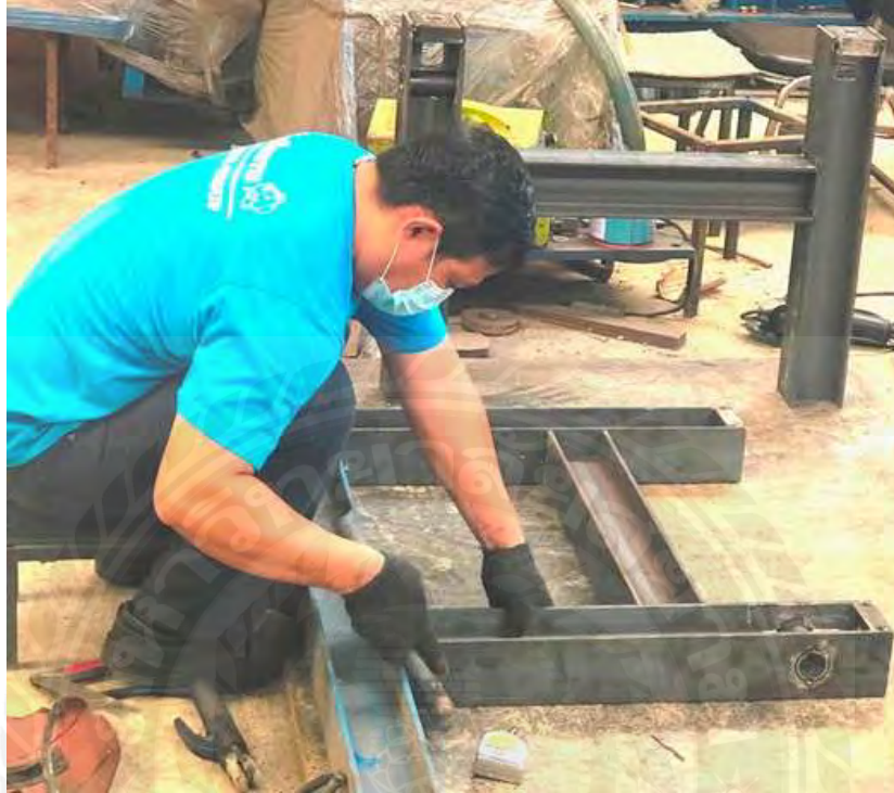
รูปที่ 3.10. การเชื่อมเหล็ก beam ทำโครงสร้างของเครื่องจักรรีดยางบาง
