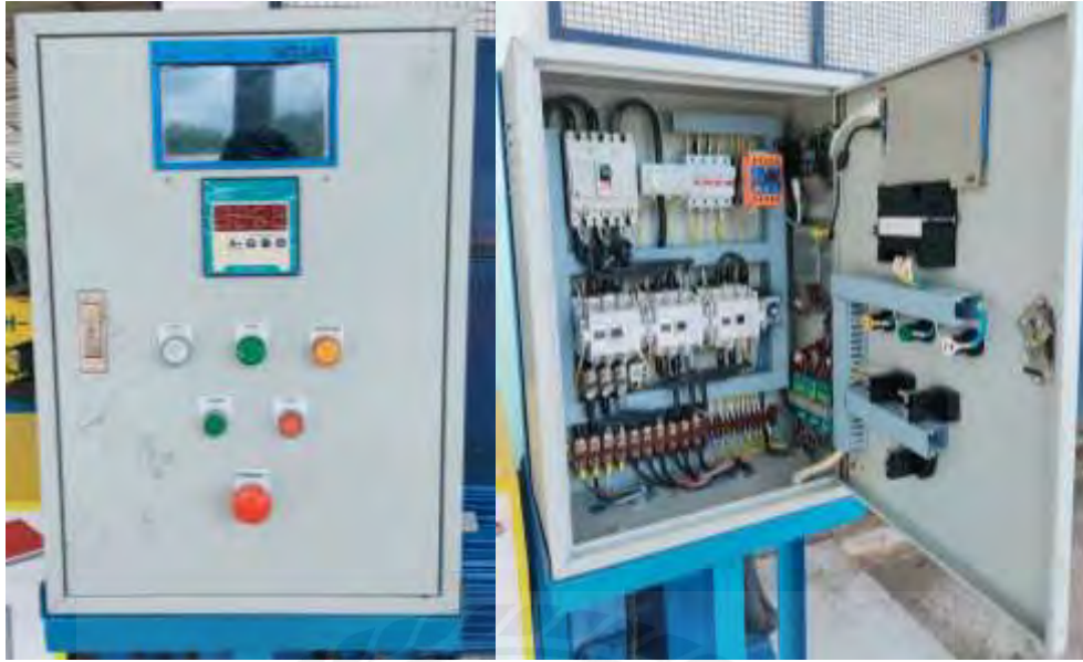
รูปที่ 3.23 ภายในและภายนอกกล่องควบคุมประกอบชุดเก็บข้อมูลทางไกลผ่านสัญญาณโทรศัพท์บ้านที่กบน
