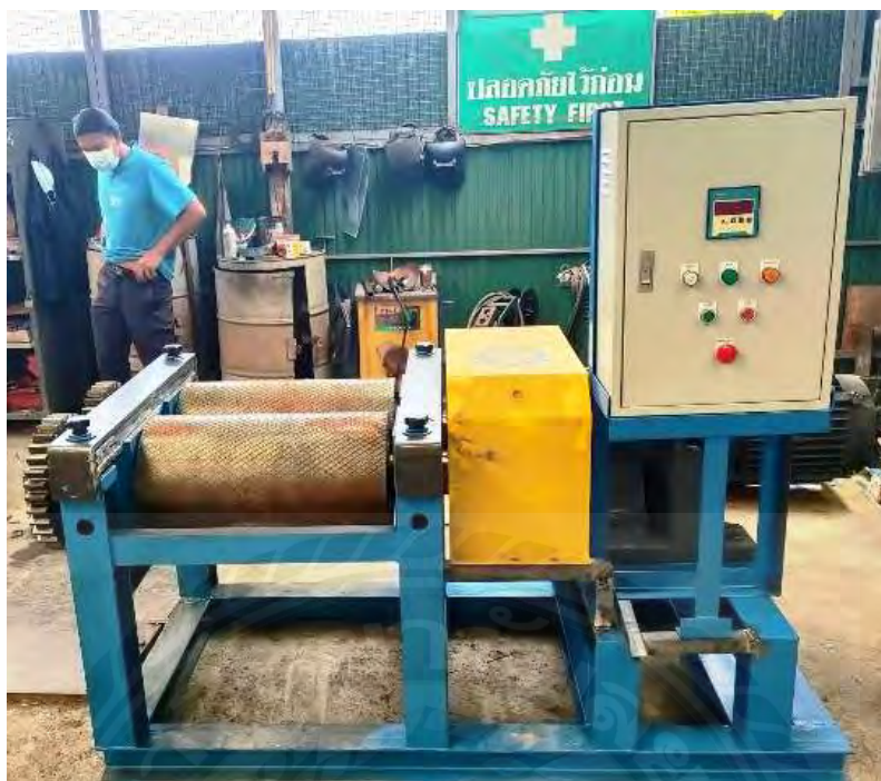
รูปที่ 3.18 ประกอบตู้ระบบไฟฟ้าที่ใช้ควบคุมความเร็วมอเตอร์เกียร์
