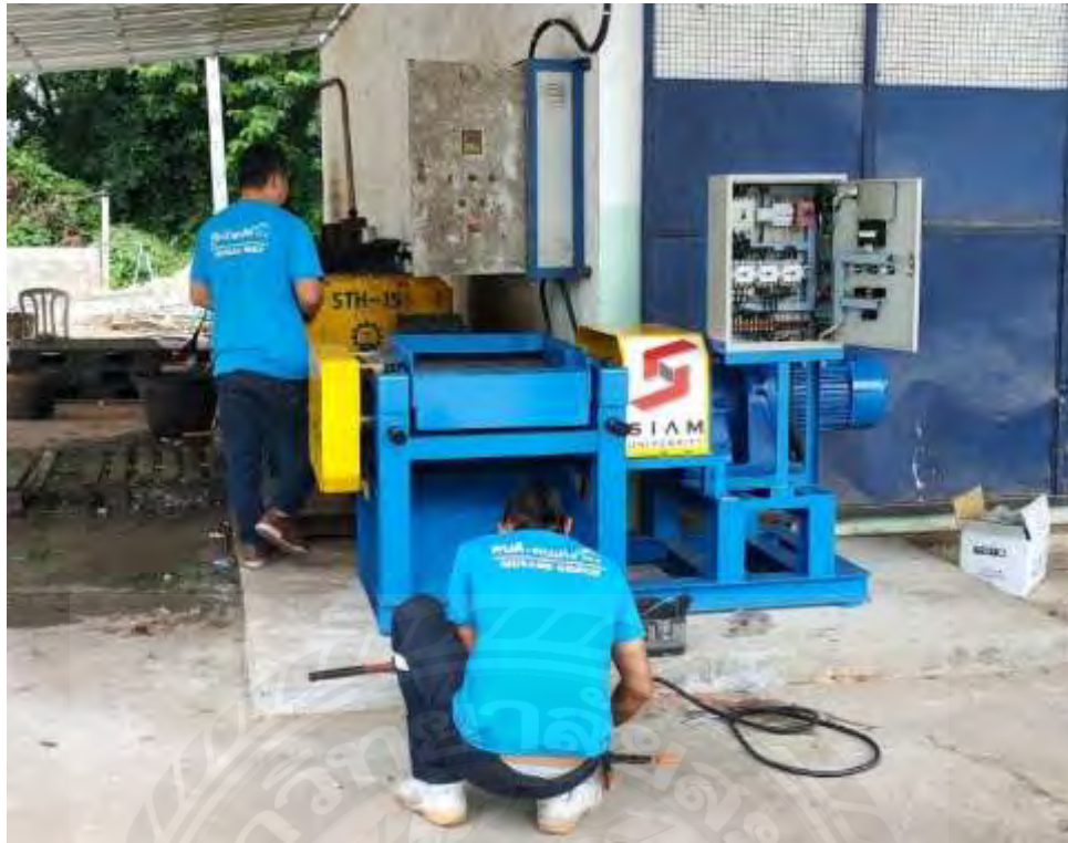
รูปที่ 5.11 ติดตั้งเครื่องจักรรีดยางเครปบาง สหกรณ์กองทุนสวนยางนิคมบ้านกรวด จำกัด ตำบลจันทบเพชร อำเภอบ้านกรวด จังหวัดบุรีรัมย์
