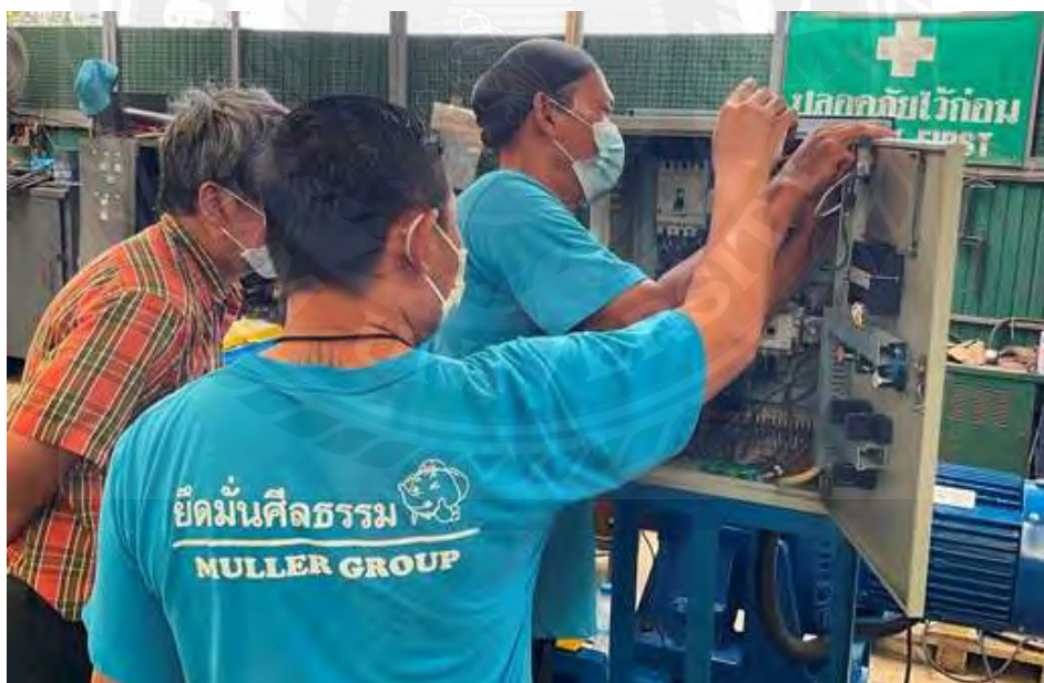
รูปที่ 3.22 ประกอบชุดเก็บข้อมูลทางไกลผ่านสัญญาณโทรศัพท์บันทึกบน Cloud computing
