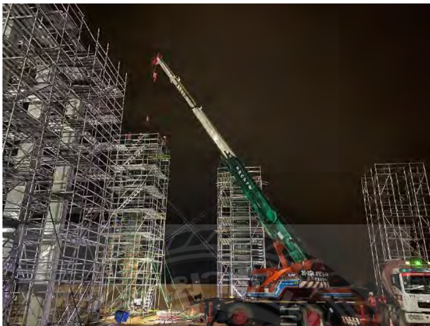
รูปที่ 3.26 การเทคอนกรีตเสา
