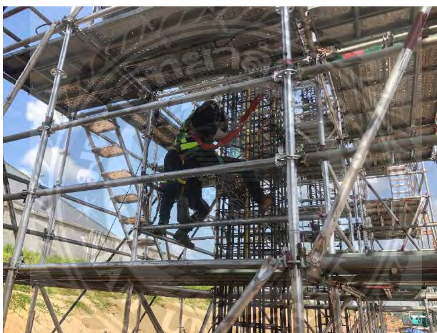
รูปที่ 3.5 การติดตั้งแผ่นเหล็ก (Plate) เสาก่อนการปรับปรุง
