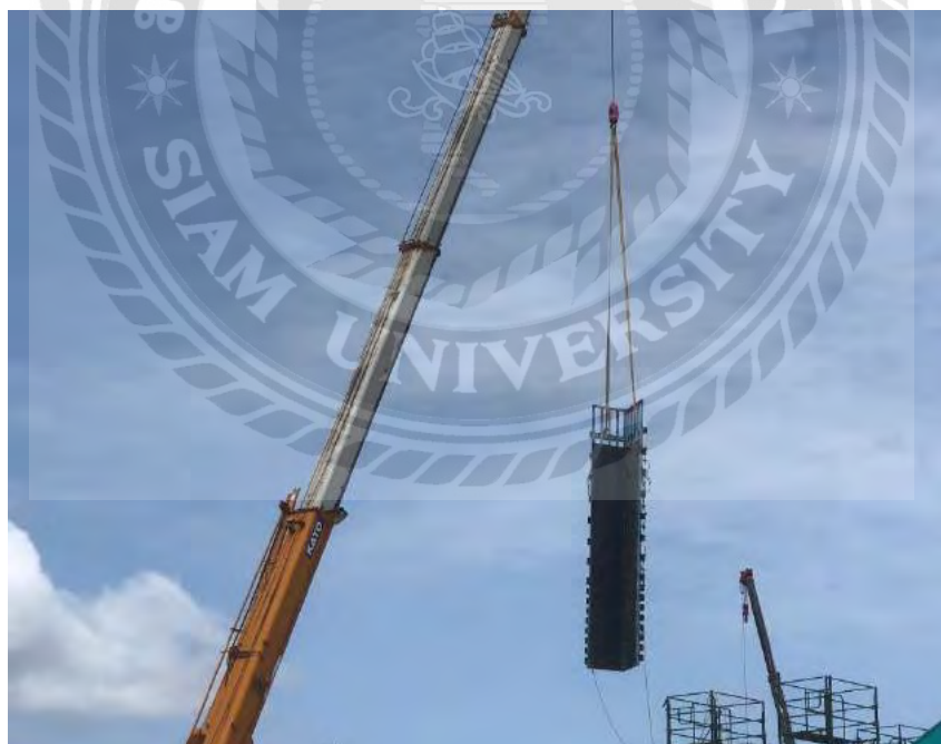
รูปที่ 3.25 การยกไม้แบบเสาเพื่อประกอบ
