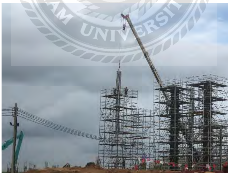
รูปที่ 3.20 การยกเหล็กเสาเพื่อติดตั้ง
