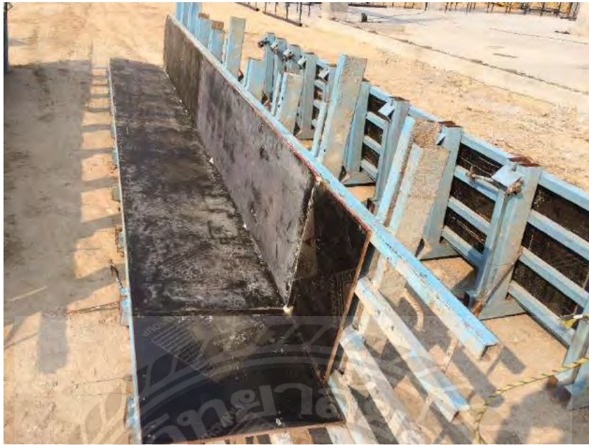
รูปที่ 3.24 การเตรียมไม้แบบเพื่อยกประกอบ
