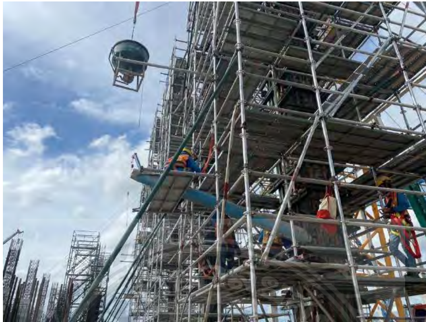
รูปที่ 3.9 การเทคอนกรีตเสาแบบเปิดช่องข้างเสา
