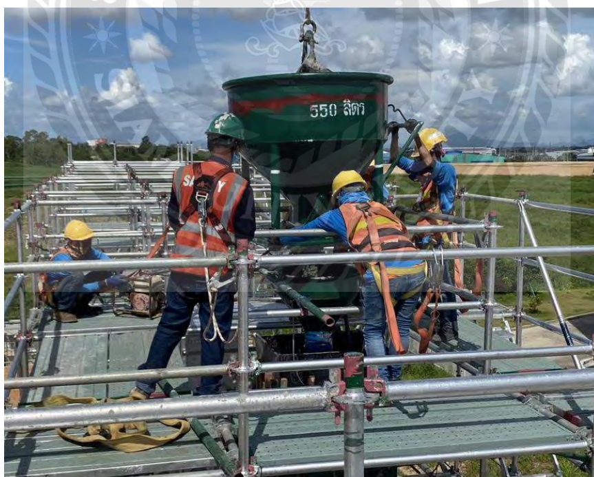
รูปที่ 3.27 การเทคอนกรีตโดยใช้กรวยและต่อท่ออ่อน
