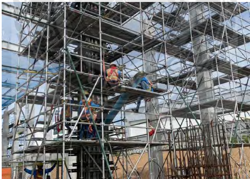
รูปที่ 3.10 ลักษณะการเทคอนกรีตเสาแบบเปิดช่องข้างเสา
