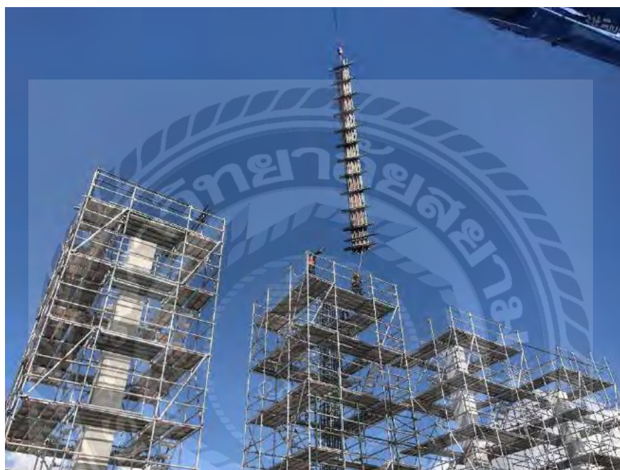
รูปที่ 3.8 การยกไม้แบบเสาเพื่อประกอบ
