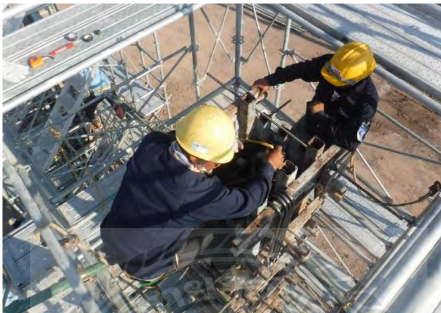
รูปที่ 3.6 การติดตั้งสลักเกลียว (Bolt) เสาก่อนการปรับปรุง
