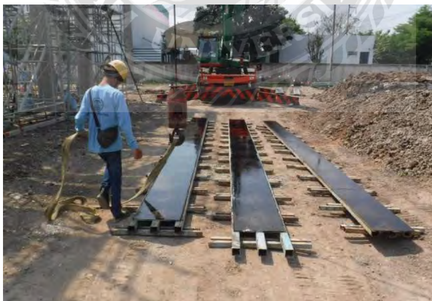
รูปที่ 3.7 การเตรียมไม้แบบเพื่อยกประกอบ
