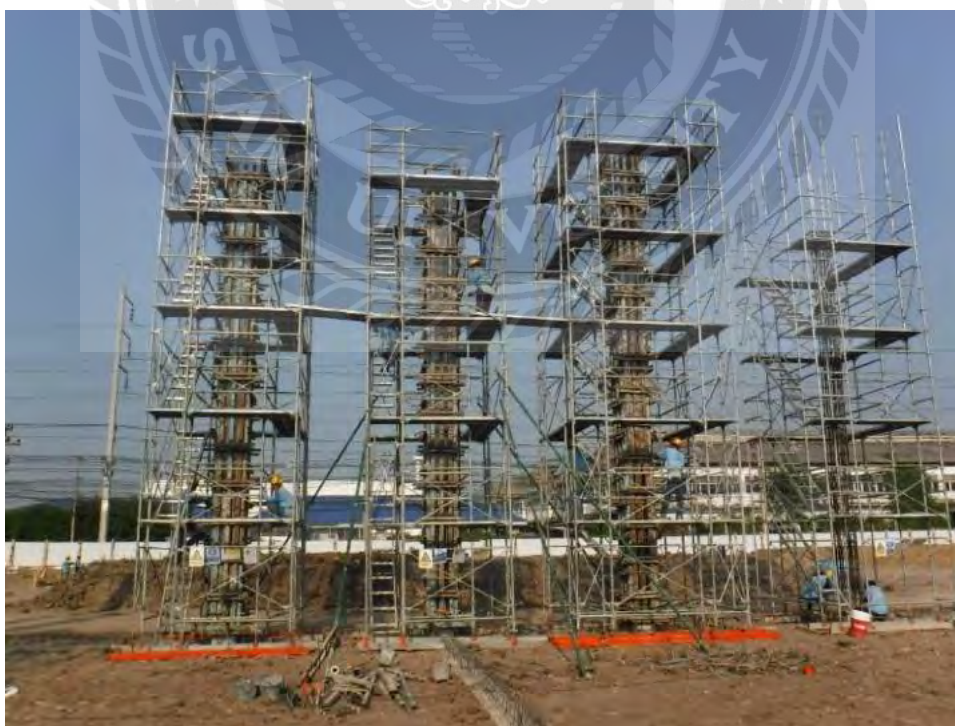
รูปที่ 1.2 ตัวอย่างเสาคอนกรีตโรงงาน
