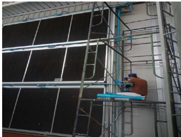
รูปที่ 4.19 การติดตั้งไทม์เมอร์
