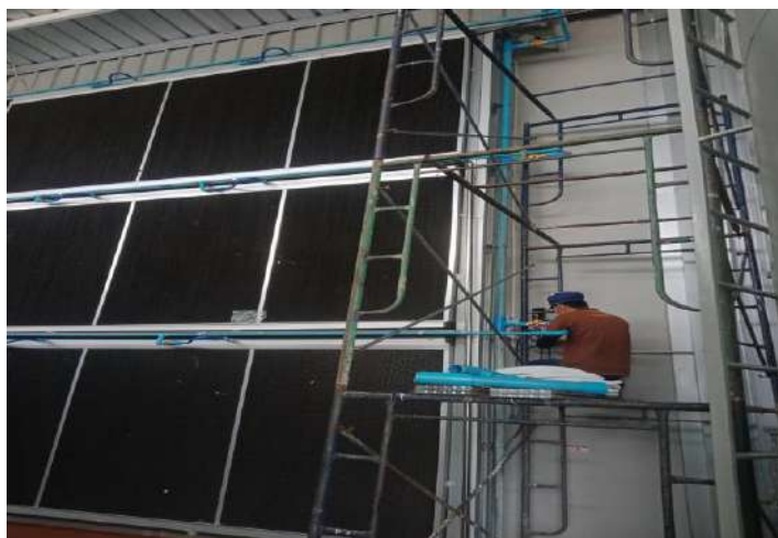
รูปที่ 9 เดินสายไฟโซลินอยไปที่ตู้ไทมเมอร์
