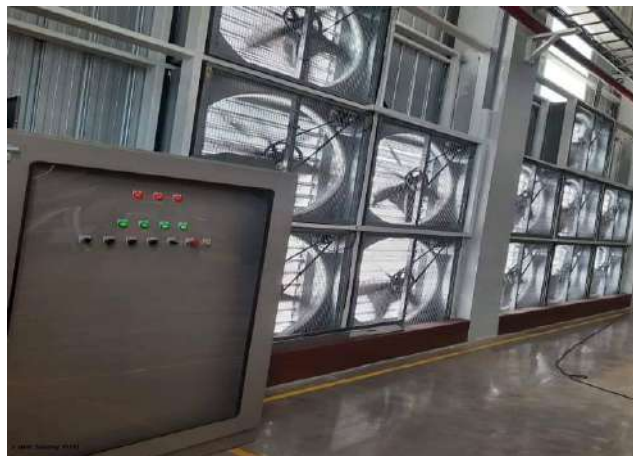
รูปที่ 4.17 การติดตั้งตู้ไฟควบคุมมอเตอร์พัดลม
