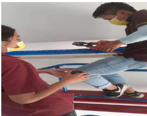
รูปที่ 4.7 การติดตั้งรางลงสายไฟ
