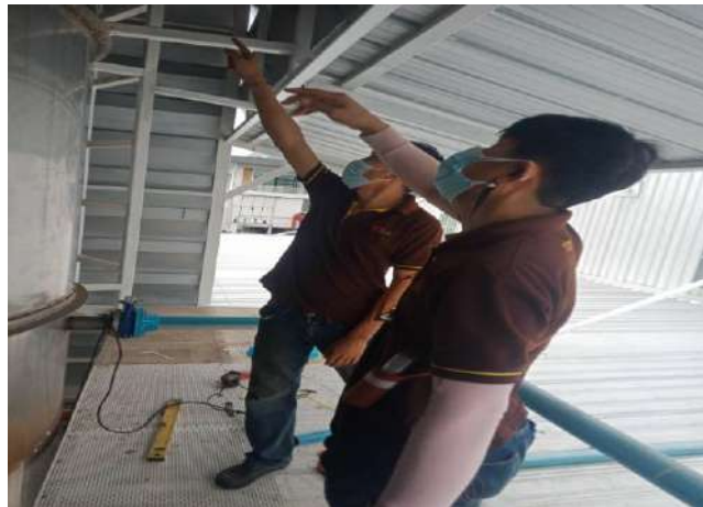
รูปที่ 4.14 ติดตั้งสวิสต์ลูกลอย
