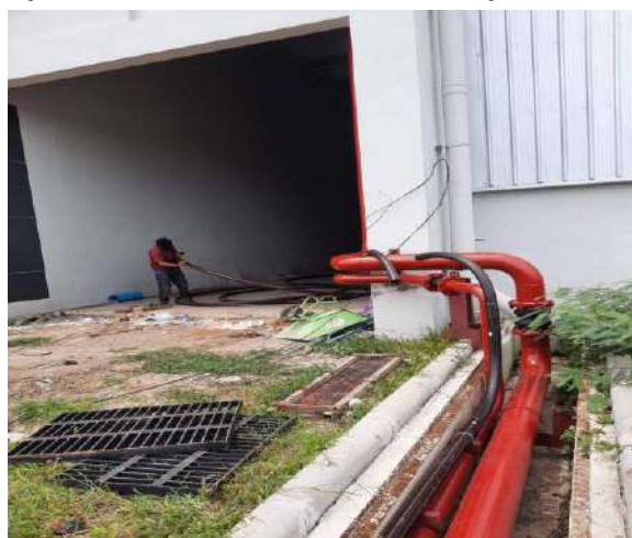
รูปที่ 4.5 ลงพื้นที่เดินสายไฟเชื่อมต่อตู้ไฟดับเพลิง
