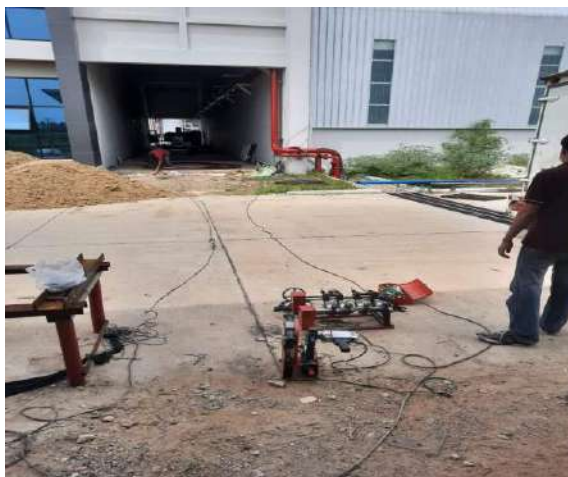
รูปที่ 4.5 ลงพื้นที่เดินสายไฟเชื่อมต่อตู้ไฟดับเพลิง
