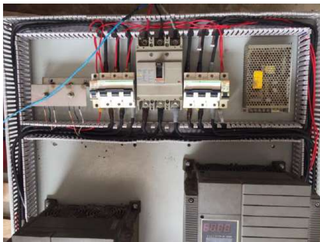
รูปที่ 4.3 การติดตั้งตู้ควบคุมมอเตอร์ปั้มน้ำ
