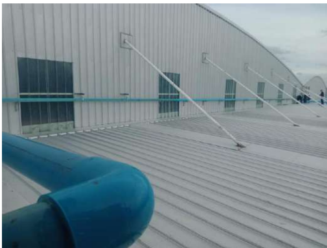
รูปที่ 4.10 ตรวจสอบการต่อท่อจากแท็งก์น้ำไปยังแผงฟิวส์
