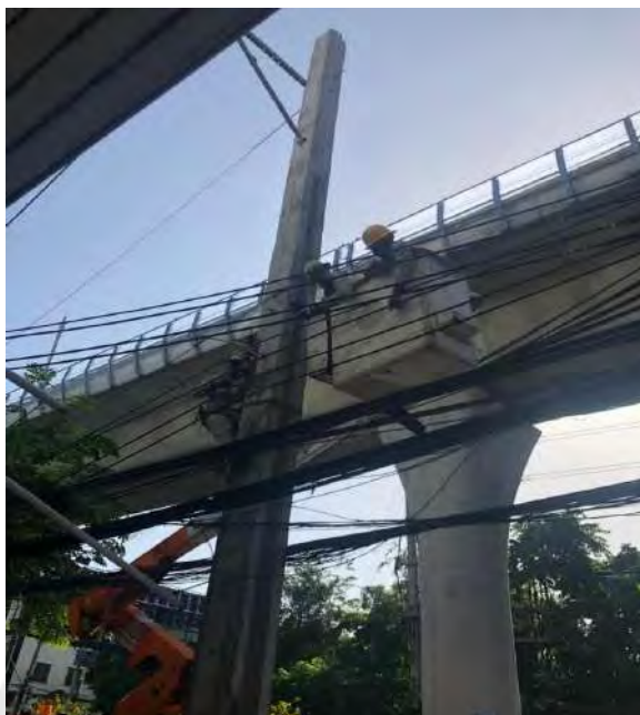
รูปที่ 4.10 การตรวจสภาพงานจริง
