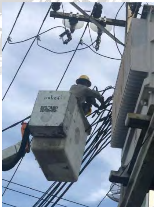
รูปที่ 2 นำตัวล๊อคสายกับสายไฟ
