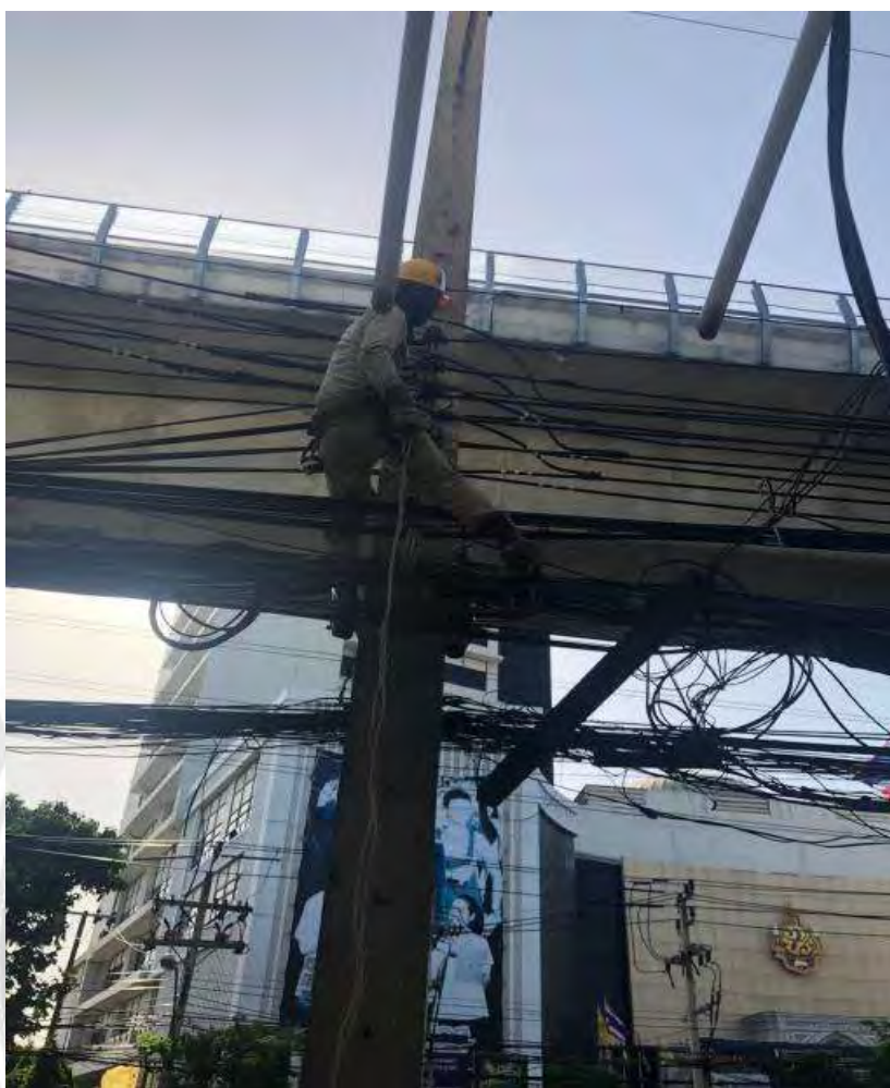
รูปที่ 4.12 การรื้อถอนสายดีเกิลิขวชำรุด
