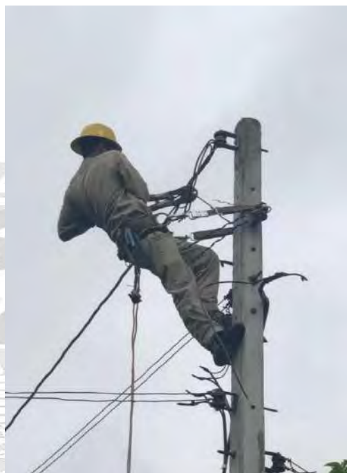
รูปที่ 2 นำตัวล๊อคสายกับสายไฟ
