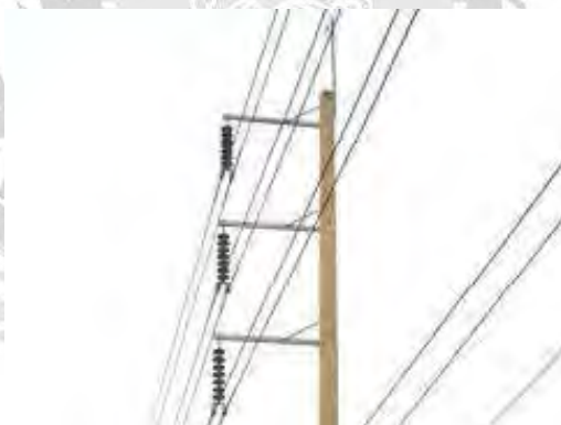
รูปที่ 2.29 ลูกถ้วยแขวนซึ่งติดตั้งในแนวดิ่ง
