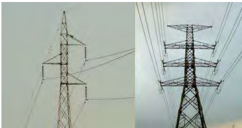
รูปที่ 2.10 เสาโครงเหล็กแบบยึดติดกับที่ใช้กับสายส่งแรงดัน 115 kV และแรงดัน 230 kV
