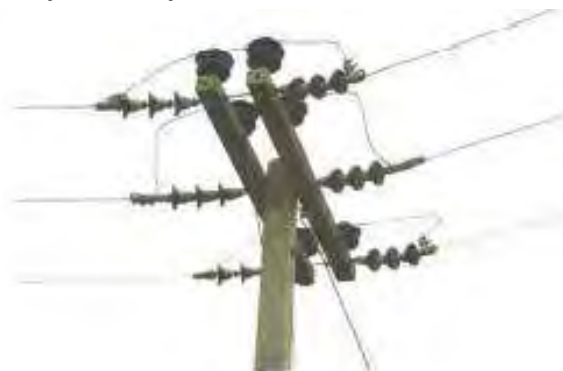
รูปที่ 2.30 ลูกถ้วยแขวนซึ่งติดตั้งในแนวนอน
