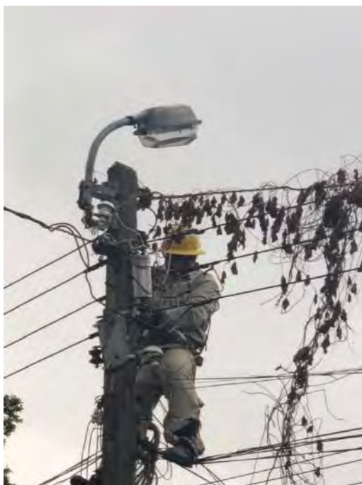
รูปที่ 1 ติดตั้งไฟถนน
