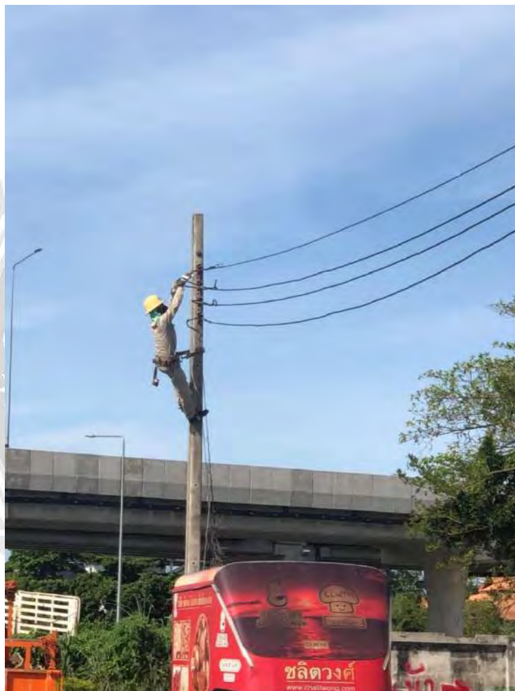
รูปที่ 4.15 ตรวจสอบความเรียบร้อยก่อนจ่ายกระแสไฟ
