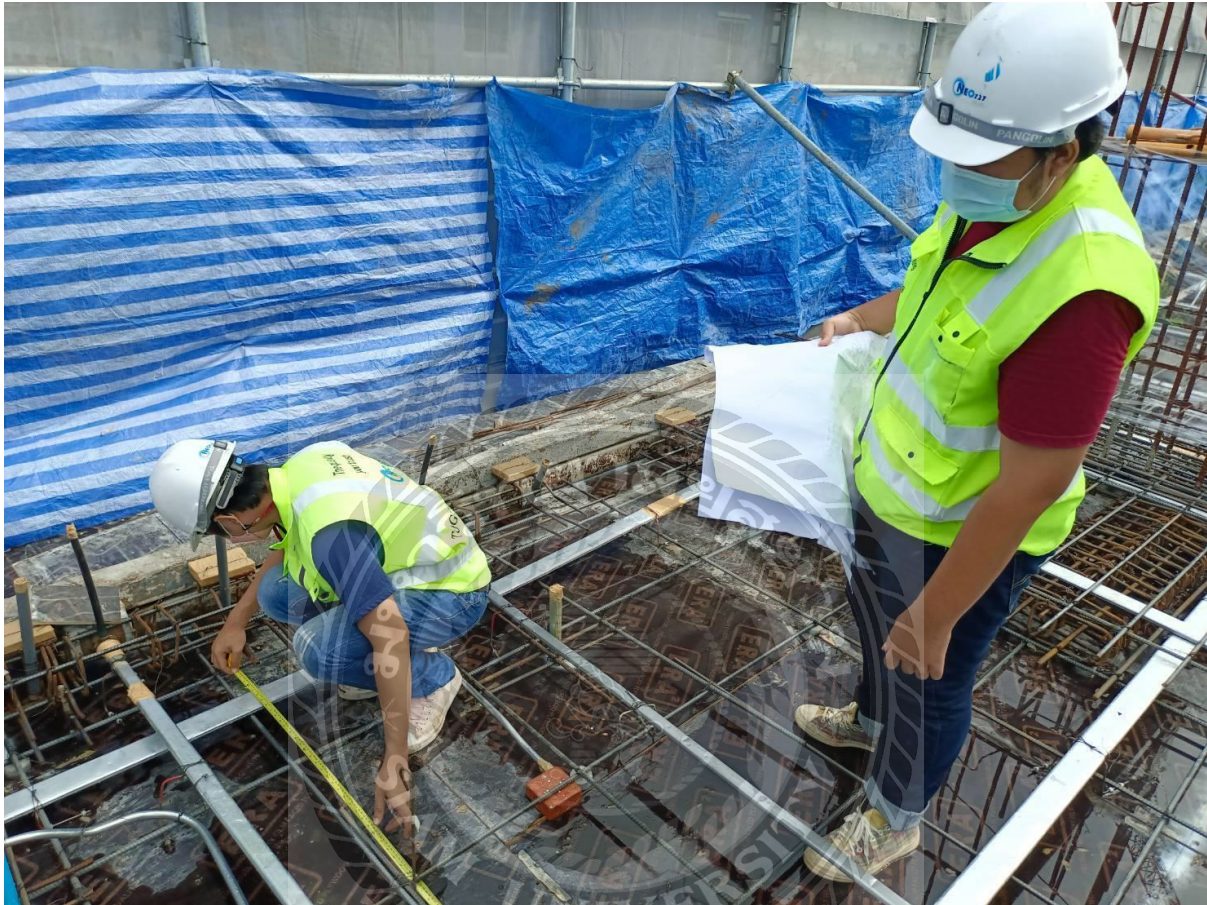
รูปที่ 4.4 การตรวจเช็คหน้างานขณะติดตั้งบล็อกไฟ
