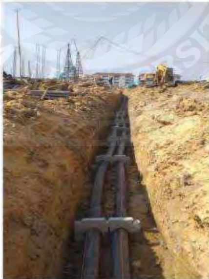
รูปที่ 2.3 DUCT BANK
