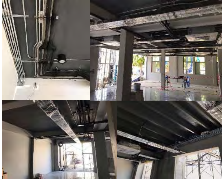
รูปที่ 4.15 ตรวจสอบงานเดินท่อระบบไฟฟ้า (ร้าน Golden-Place สาขาเพชรบุรี)
