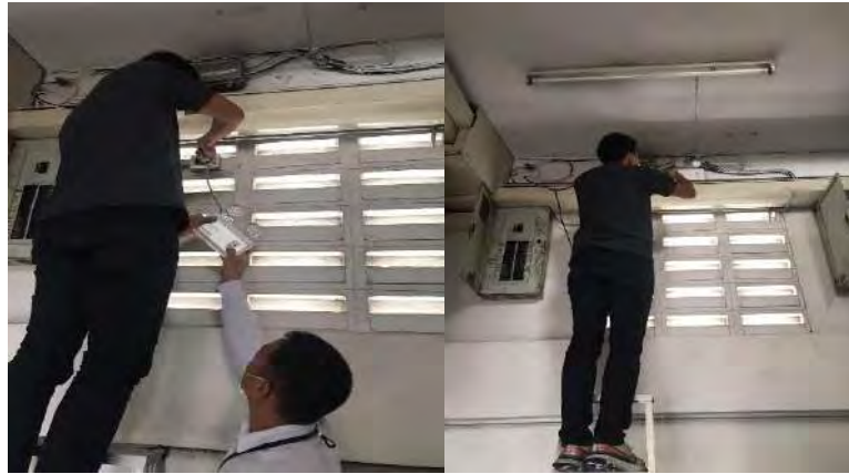
รูปที่ 4.13 ติดตั้งไฟฉุกเฉิน Emergency light (อพาร์ทเมนท์เทพประทาน)
