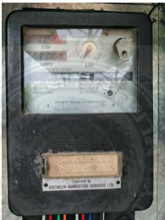
รูปที่ 2.15 มิเตอร์ 3 เฟส 4 สาย ประกอบ ซีที แรงต่ำ ชนิดจานหมุน
