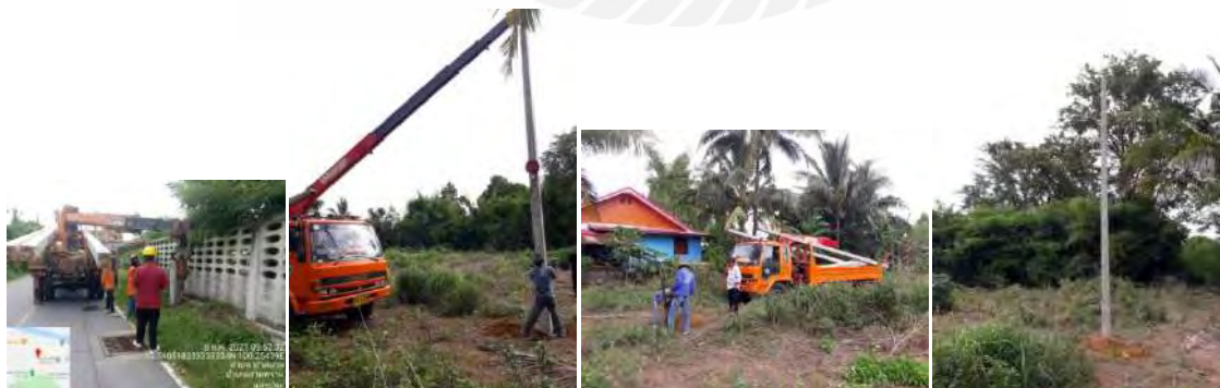
รูปที่ 4.11 การขุดหลุมปักเสาไฟฟ้า
