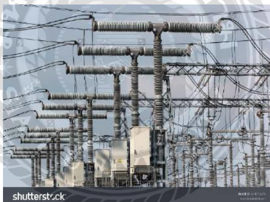
รูปที่ 2.10 High Voltage Circuit Breakers
