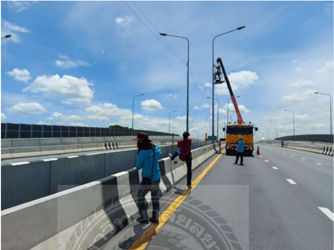
รูปที่ 4.6 ทำการติดตั้งสายไฟฟ้าขึ้นที่สูง
