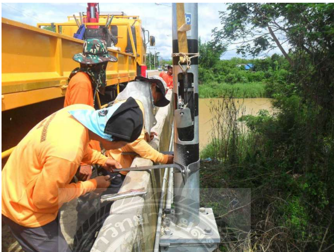
รูปที่ 4.5 การติดตั้งเสาไฟฟ้าแสงสว่าง
