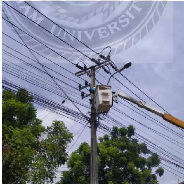
รูปที่ 4.11 ทำการนำถุงมือผ้าคลุมปิดบริเวณ เซ็นเซอร์ตรวจจับแสง
