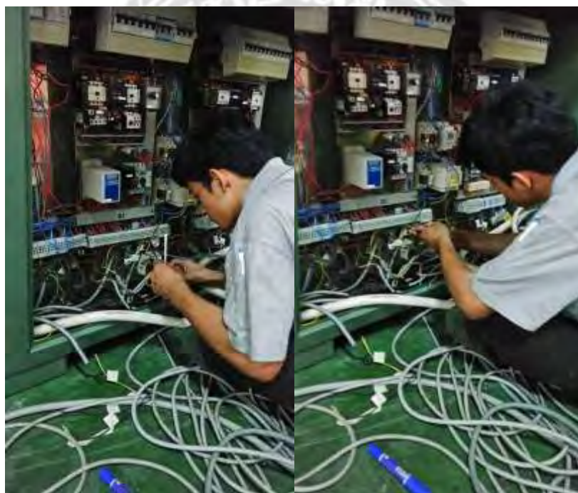
รูปที่ 4.40 นำสายไฟมาทำการเชื่อมต่อกับอุปกรณ์ไฟฟ้าในตู้ควบคุม
