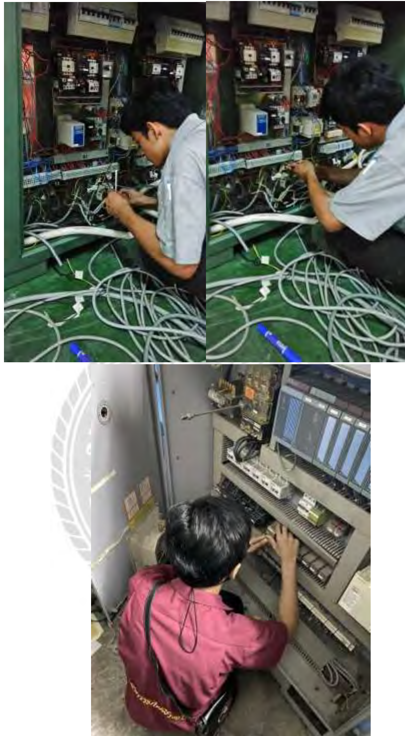
รูปที่ 4.15 การเปลี่ยนอุปกรณ์ไฟฟ้าให้กับตู้ควบคุมเครื่องเย็บสันหนังสือ
