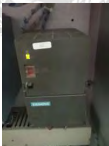
รูปที่ 4.11 สวิตชิงเพาเวอร์ซัพพาย
