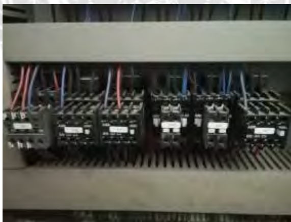
รูปที่ 4.48 แมคเนติกคอนแทกเตอร์ทั้ง 6 ตัว
