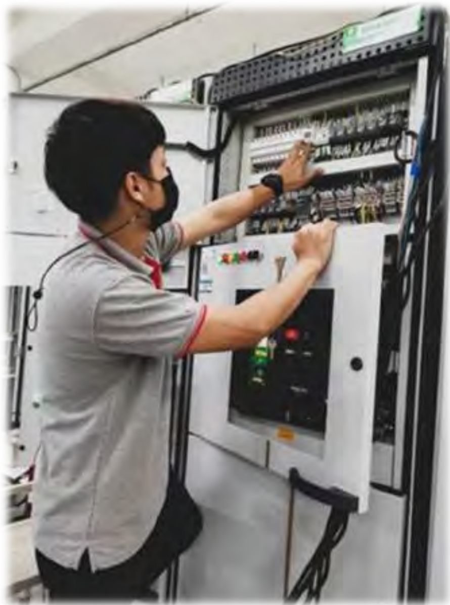
รูปที่ 4.9 การเช็คเฟสโปรเทคชั่นรีเลย์ (Phase Protection Relay)
