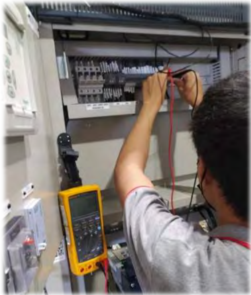
รูปที่ 4.8 การเช็คความต่อเนื่องของวงจร
