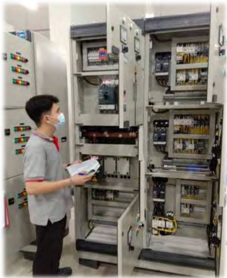
รูปที่ 4.7 การเช็คอุปกรณ์ภายในตู้สวิตช์บอร์ด
