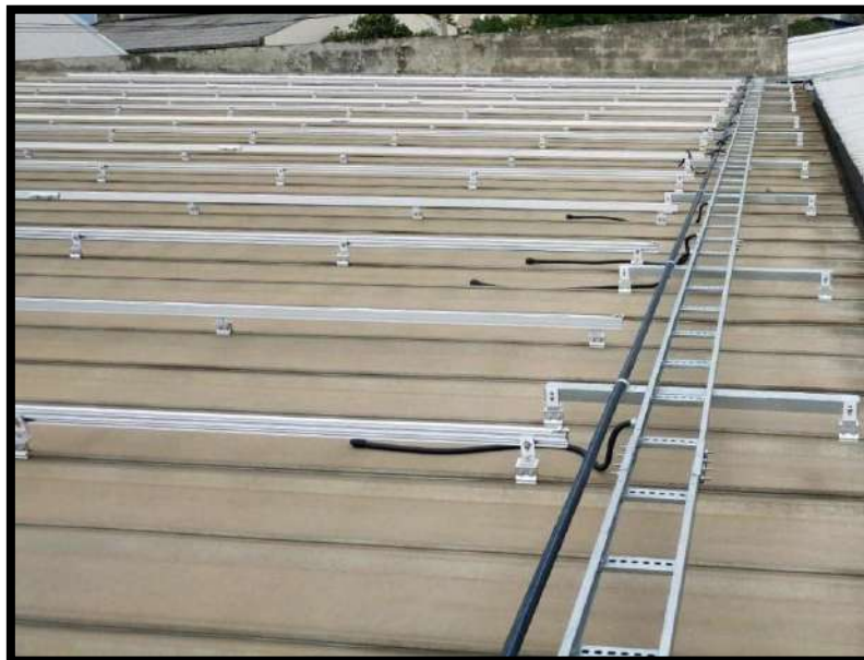
รูปที่ 3.3 Support แผงโซลาร์เซลล์
