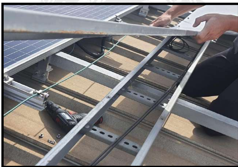
รูปที่ 3.6 ทำการร้อยสายไฟเข้ารางไฟ
