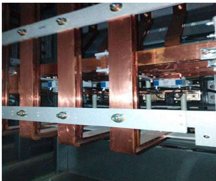
รูปที่ 2.15 บัสบาร์ (Busbar)
