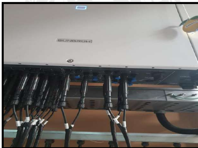
รูปที่ 3.8 ต่อสาย DC เข้า Invertor
