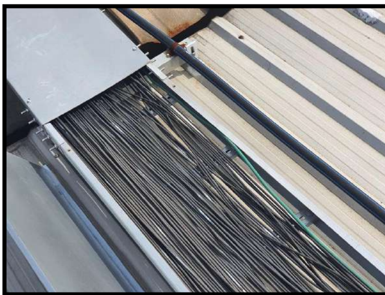
รูปที่ 3.7 ทำการพาดสาย DC และ สาย Ground
