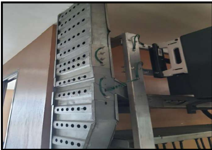
รูปที่ 3.9 ติดตั้งรางเดินสายไฟไปยัง ตู้ MDB
