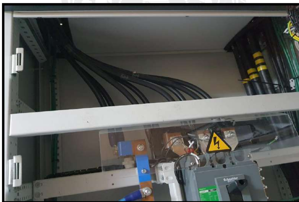
รูปที่ 3.12 ต่อสาย AC 3 เฟส ไปเข้ารางสายไฟ
