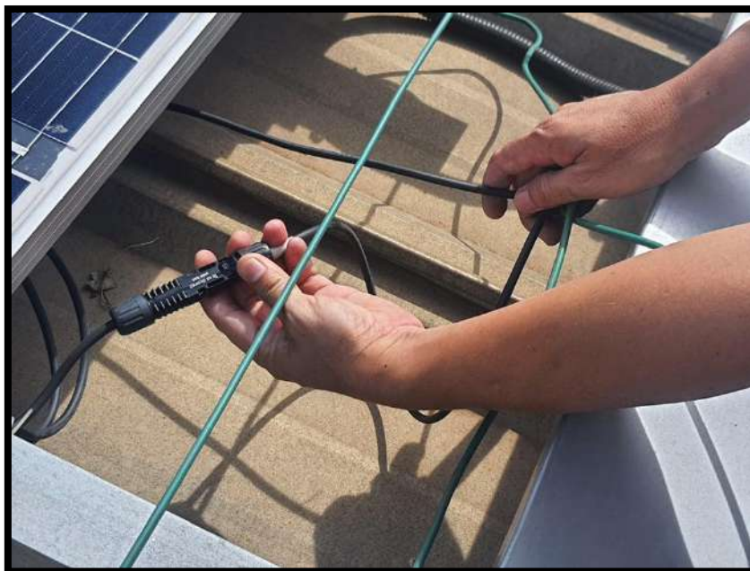
รูปที่ 3.5 ทำการต่อสายไฟที่ออกจากแผงโซลาร์เซลล์
