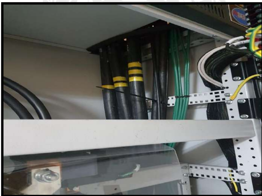
รูปที่ 3.10 ร้อยสาย AC และ สาย Ground เข้า ตู้ MDB
