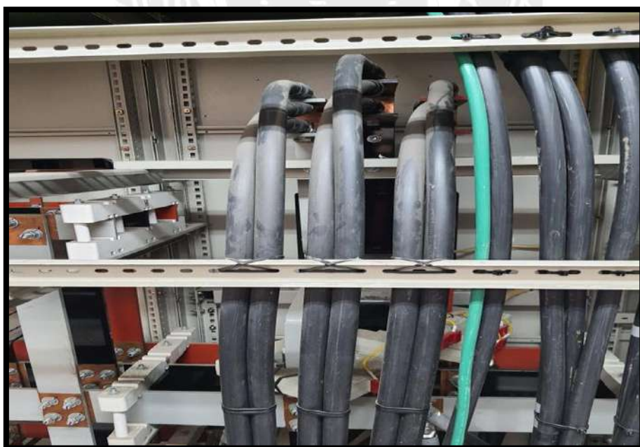
รูปที่ 3.14 เดินสาย AC 3 เฟสเข้าตู้ MBD
