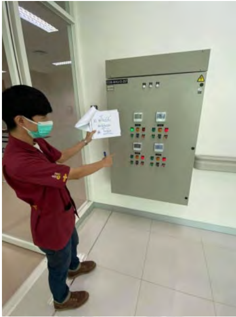
รูปที่ 4.2 ทำการตรวจเช็คตู้ AHU พร้อมทำการแก้ไข
