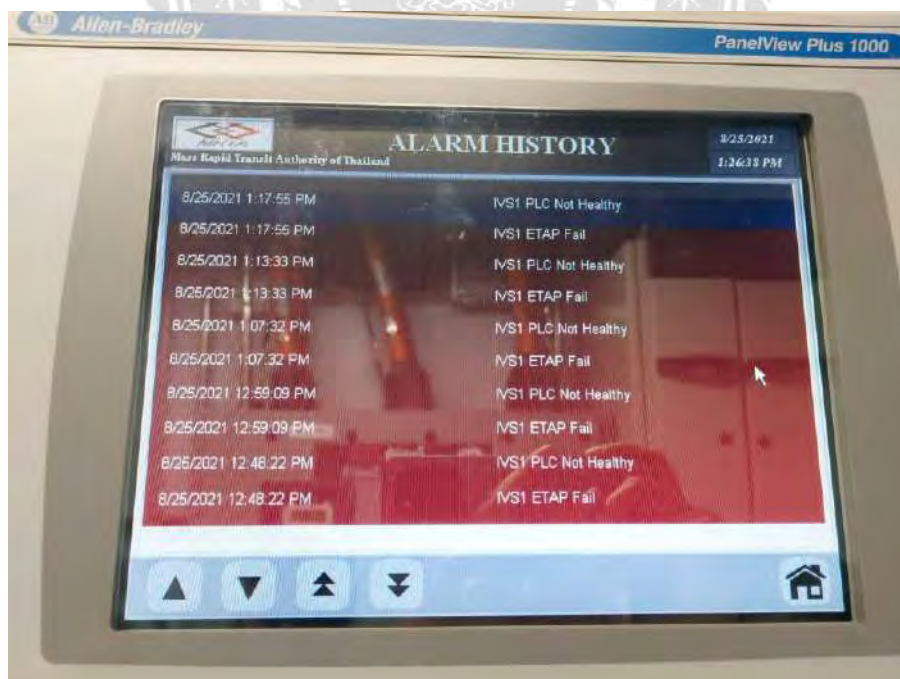
รูปที่ 2.17 หน้าจอแสดงการแจ้งเตือน Alarm
