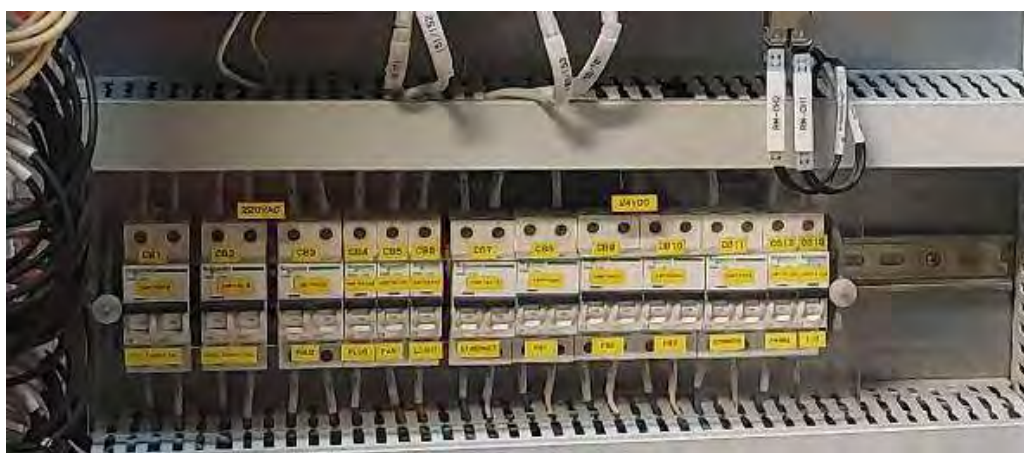
รูปที่ 2.6 Circuit Breaker
