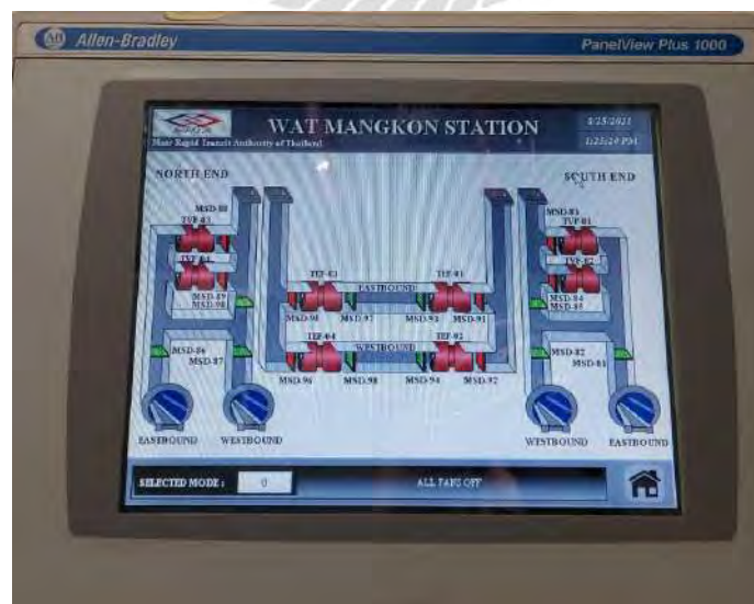
รูปที่ 2.15 กราฟิกที่แสดงในส่วนภาพรวมของระบบระบายอากาศในอุโมงค์
