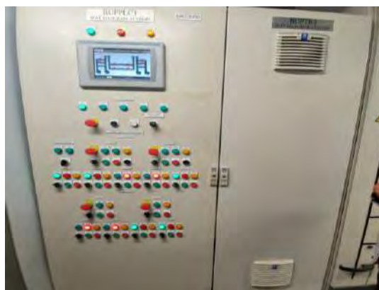
รูปที่ 2.1 ด้านหน้าตู้ควบคุมระบบระบายอากาศในอุโมงค์ (VCP)
