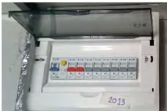
รูปที่ 4.17 คอนซูมเมอร์ยูนิต (Consumer Unit)
