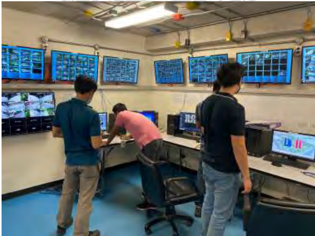
รูปที่ 11 ตรวจสอบการใช้งานหลังทำการซ่อมบำรุง
