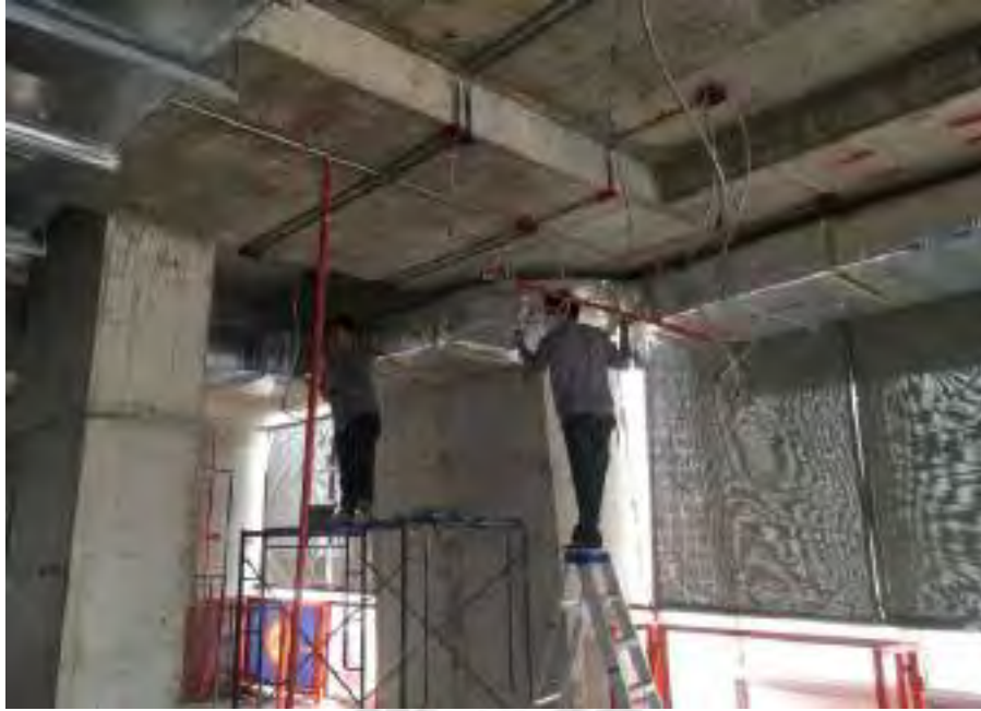
รูปที่ 3.3 เดินท่อร้อยสายไฟฟ้า
