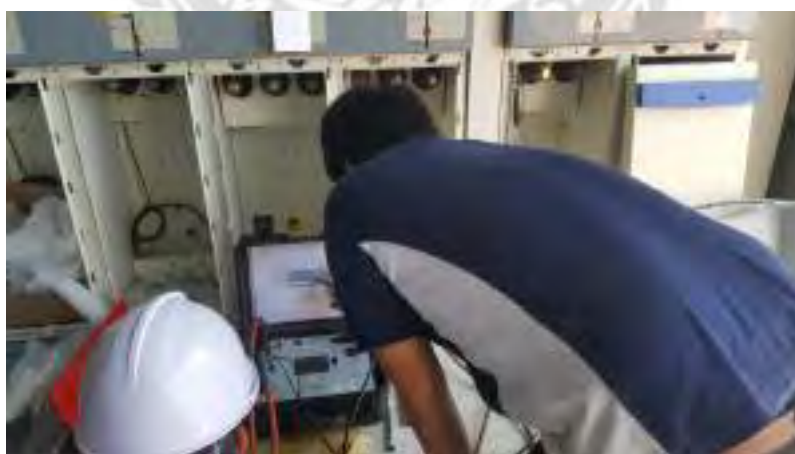
รูปที่ 4.9 การติดตั้งเซอร์กิตเบรกเกอร์ MCCB
