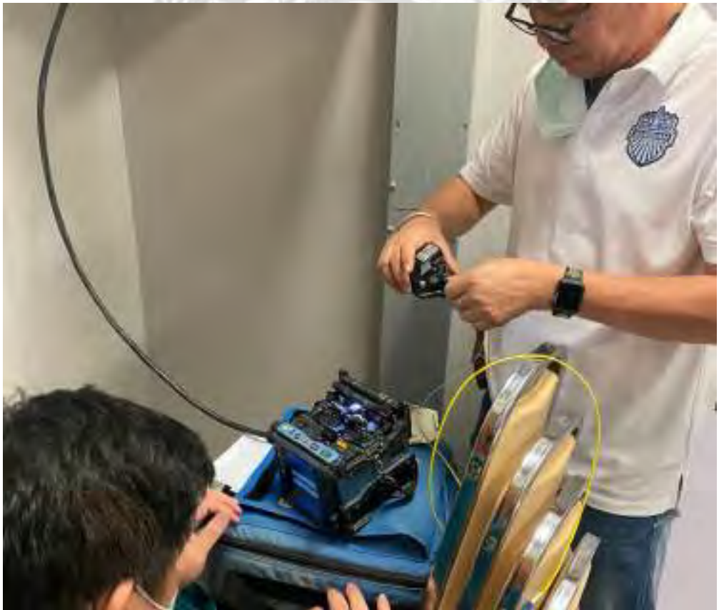
รูปที่ 6 สไปร์สายไฟเบอร์ กว้างจรปิดในจุดที่ชำรุดเสียหาย
