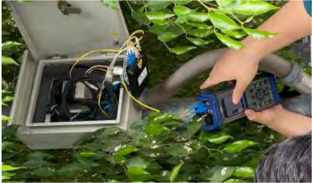
รูปที่ 5 หาจุดที่ชำรุดในสายไฟเบอร์ กว้างจรปิด
