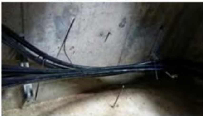
รูปที่ 4.3 การเดินสายท่อใต้ดิน
