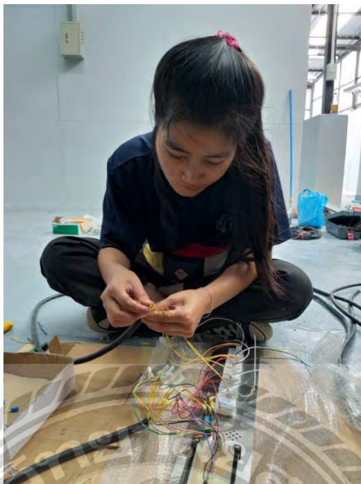
รูปที่ 4.3 การต่อวงจรสวิตช์ปุ่มกดหน้าชั้น
