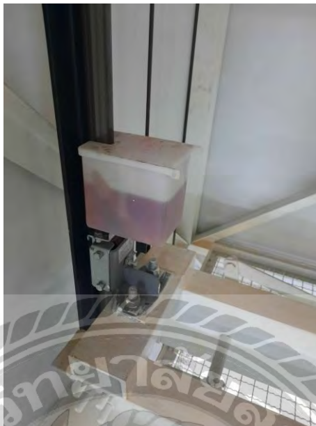
รูปที่ 4.10 เติมน้ำมันรางลิฟท์
