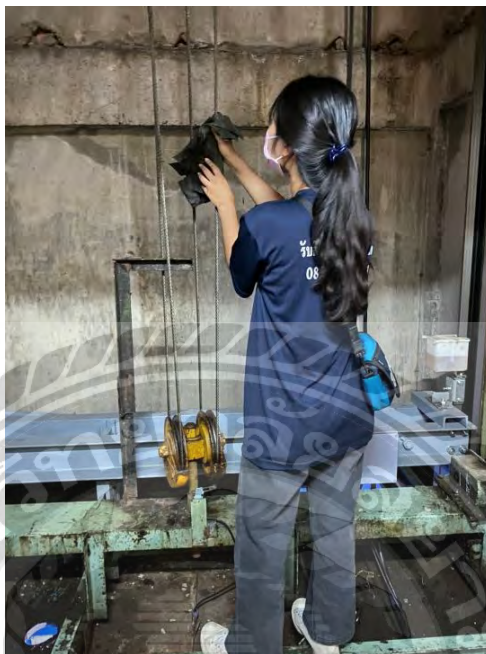
รูปที่ 4.9 ตรวจสอบสลิง
