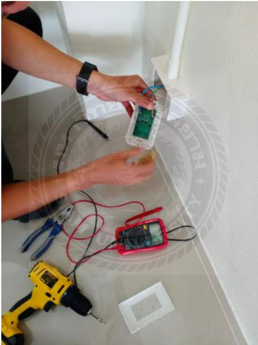
รูปที่ 4.2 รูปแสดงถึงหลักการทำงานเบื้องต้นของการตรวจเช็คกระแสไฟฟ้า
