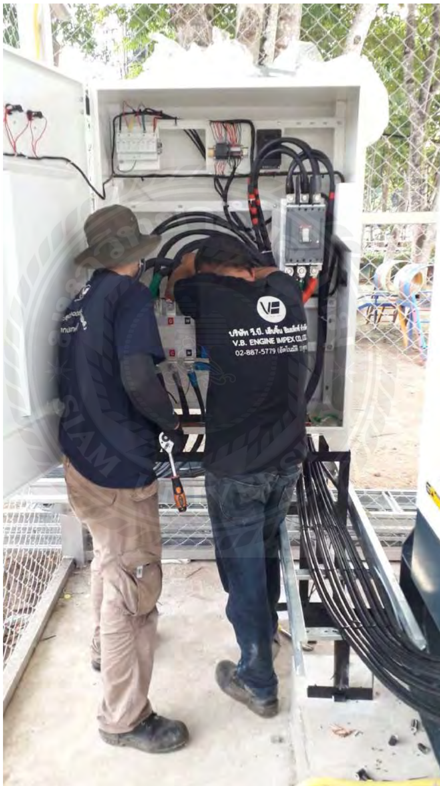
รูปที่ 4.17 ติดตั้งตู้เบรกเกอร์
