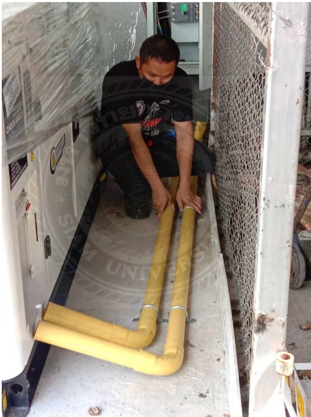
รูปที่ 4.19 เดินสายจากตู้เบรกเกอร์เข้าเครื่อง
