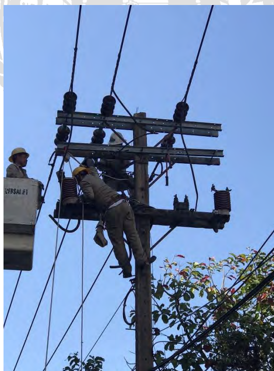
รูปที่ 4.8 รูปขณะทำการติดตั้ง CT
