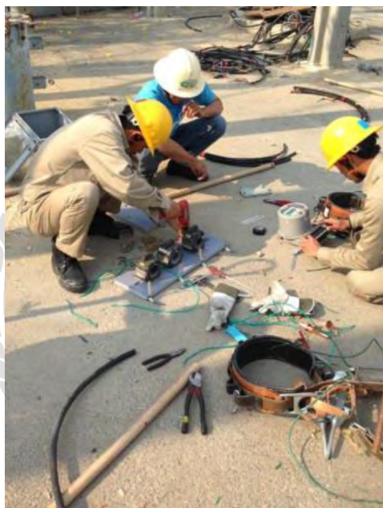
รูปที่ 4.9 รูปขณะแก้ไขการต่อสาย Control ของ CT ใหม่
