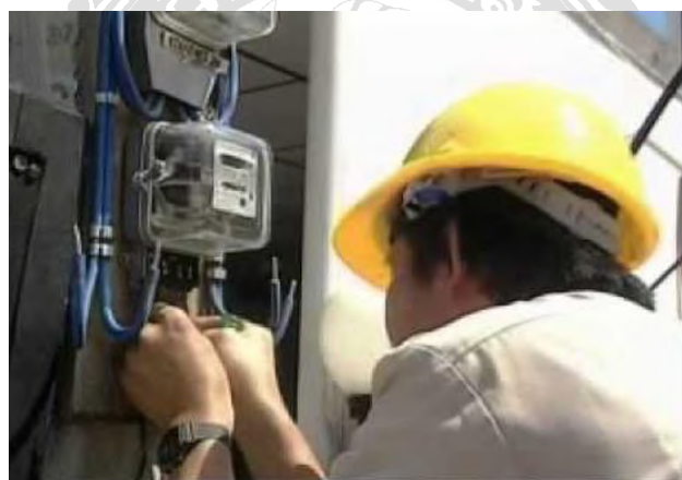
รูปที่ 4.4 รูปขณะทำการติดตั้งเข้าสายมิเตอร์ไฟฟ้า
