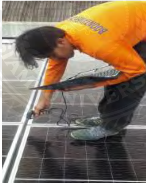
รูปที่ 4 การตรวจเช็คแผงโซล่าเซลล์
