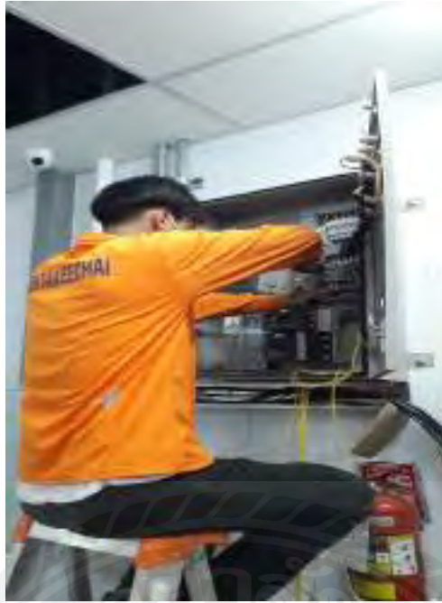
รูปที่ 1 การเข้าสายตู้ DB-01
