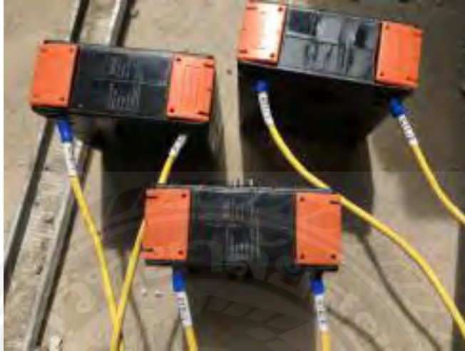
รูปที่ 4.25 CT หม้อแปลงวัดกระแส
