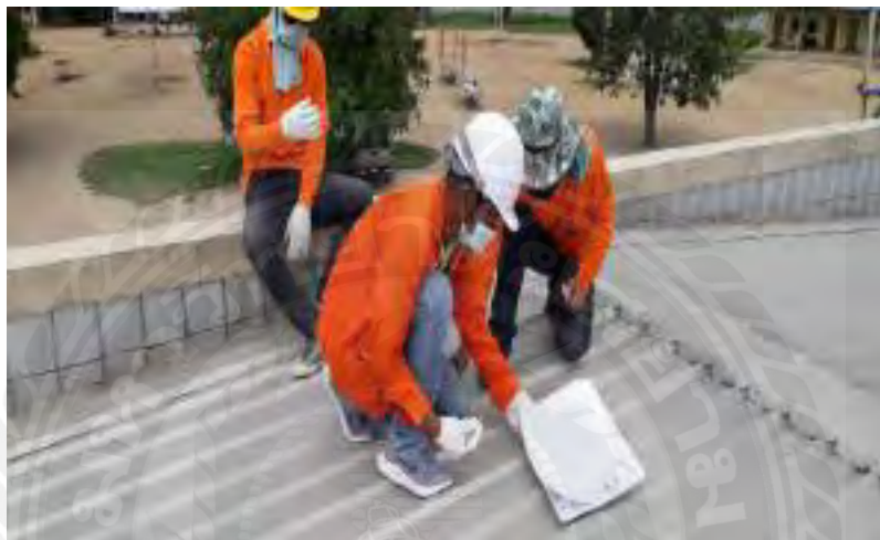
รูปที่ 4.6 การวางแผนติดตั้งโครงสร้าง
