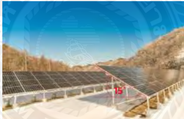
รูปที่ 2.3 การตั้งแผงโซลาร์เซลล์เอียงทำมุม15องศา
