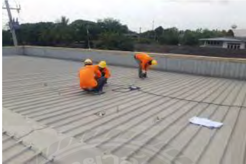
รูปที่ 4.12 ติดตั้ง L-Fee ยึดหลังคาเมทัลชีส
