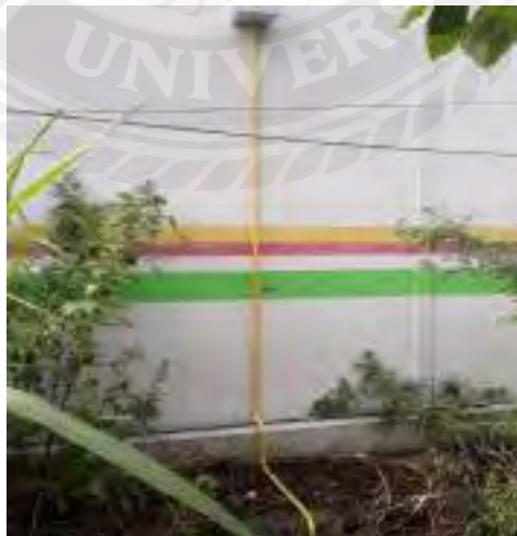
รูปที่ 4.28 การเดินท่อกราวด์ลงหลักดิน
