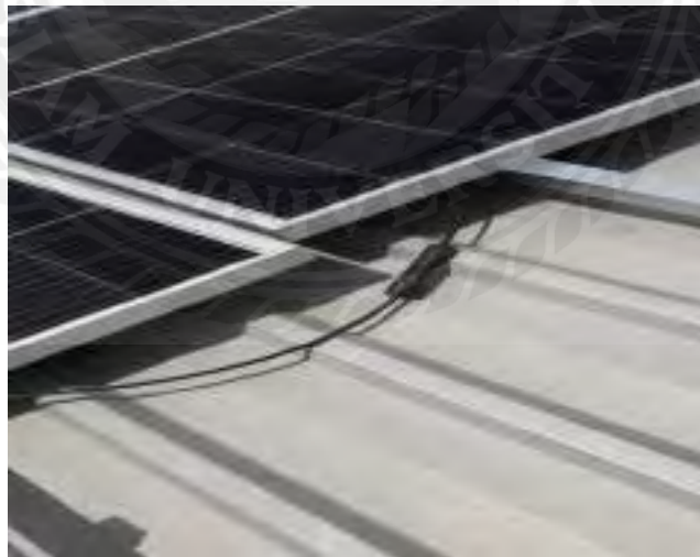
รูปที่ 4.15 ต่อสายแผงโซลาร์เซลล์เข้ากัน
