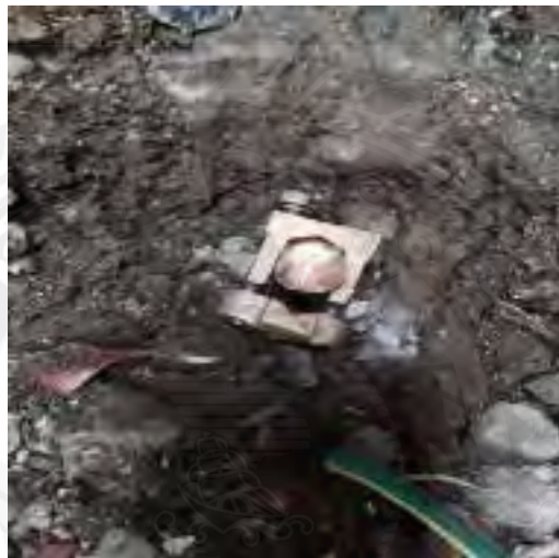
รูปที่ 4.27 การใช้ Clamp ยึดสกรูกับหลักดิน
