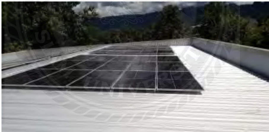
รูปที่ 4.17 ติดตั้งแผงโซลาร์เซลล์แล้วเสร็จ
