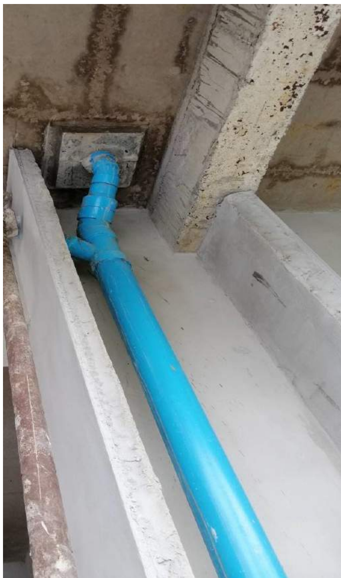
รูปที่ 4.6 การเดินท่อในช่องชาร์ป
