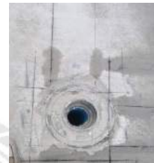
รูปที่ 4 การตีเส้นรางน้ำฝนและการวางฐานรูปพรรณ
