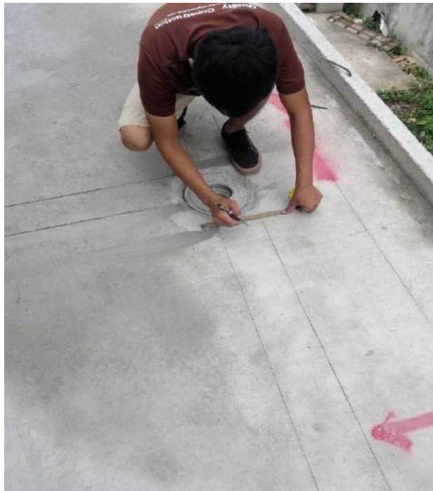
รูปที่ 1 การวัดระยะรางน้ำฝน
