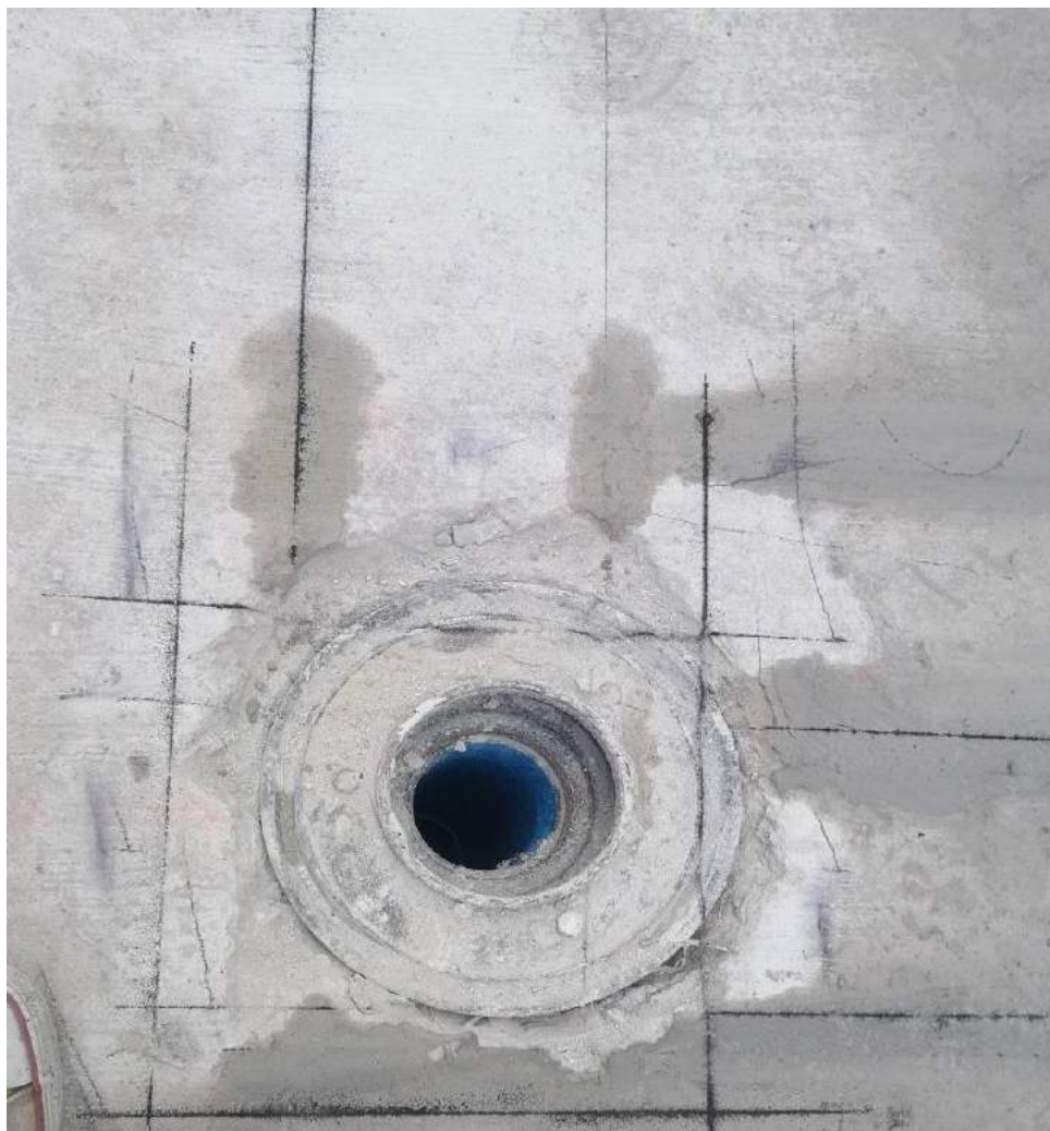
รูปที่ 4.4 การตีเส้นรางน้ำฝนและการวางฐานรูฟเดรน
