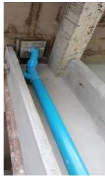
รูปที่ 6 การเดินท่อในช่องชาร์ป
