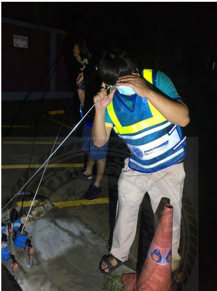
รูปที่ 3.18 เดินสำรวจหาท่อประปารั่วโดยใช้อุปกรณ์ Acoustic Rod
