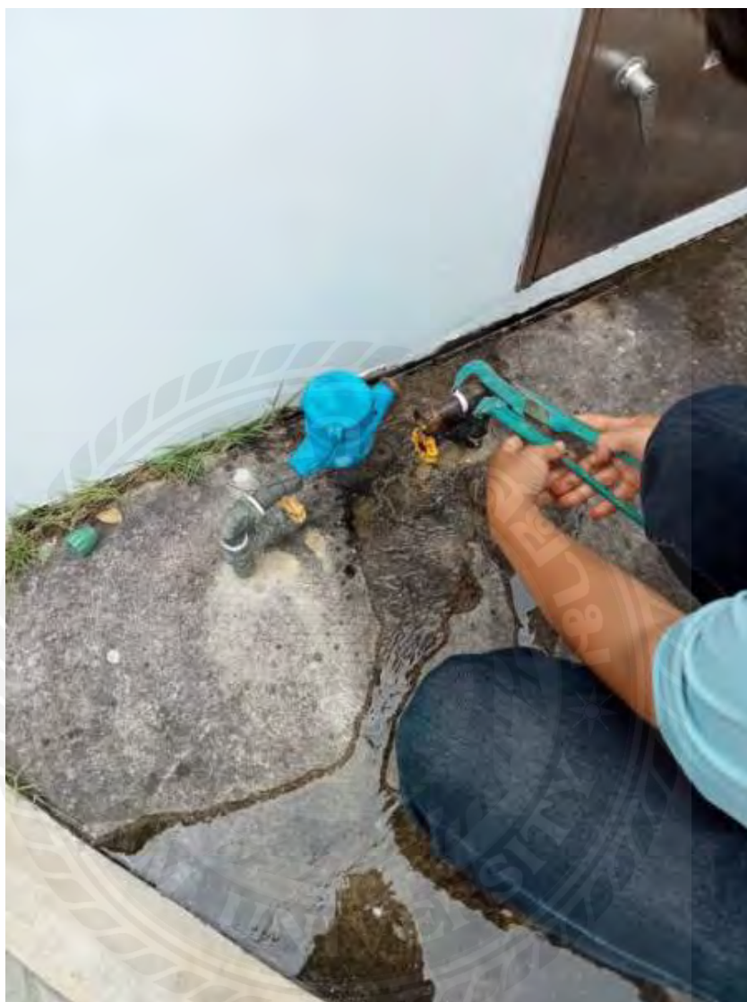
รูปที่ 3.15 ตรวจสอบมาตรว่าปิดน้ำสนิทหรือไม่
