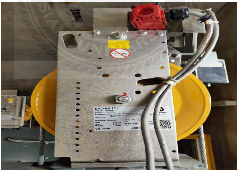
รูปที่2.11 กลไกกลชุดโกวาเนอร์(GBP Govaner)
