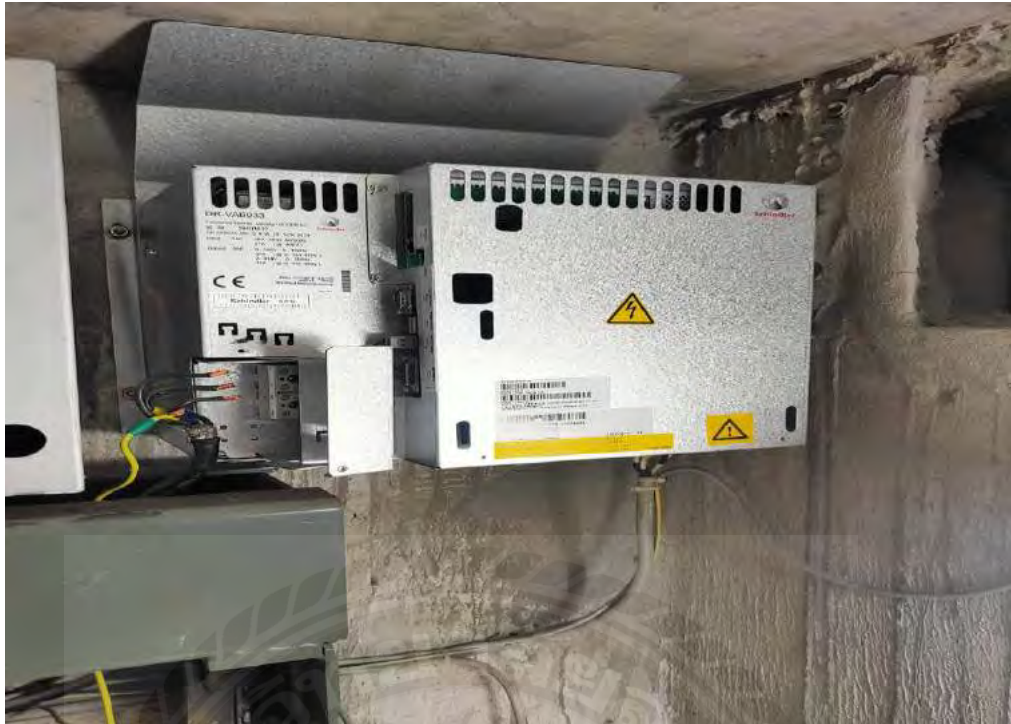
รูปที่ 2.8 ชุดไดฟ้ระบบควบคุมการขับเคลื่อน(Drive control)
