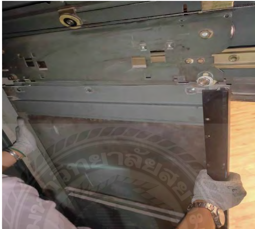
รูปที่ 3.10(A) การถอดยกบานประตูและนำออก
