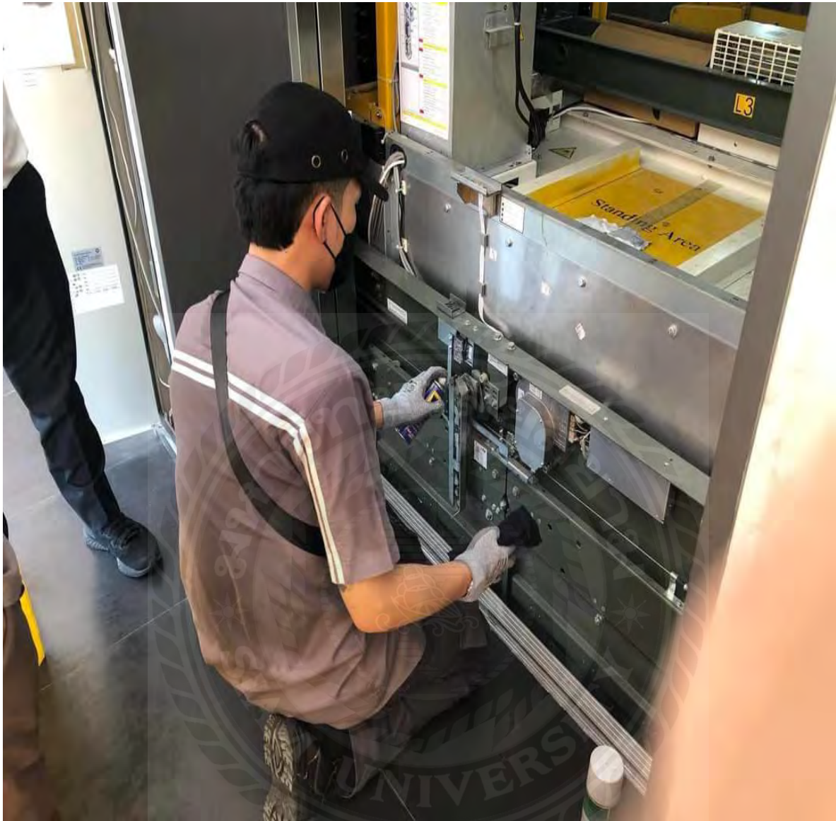
รูปที่ 1 การตรวจสอบและหล่อถิ่นชุดประตูลิฟต์
