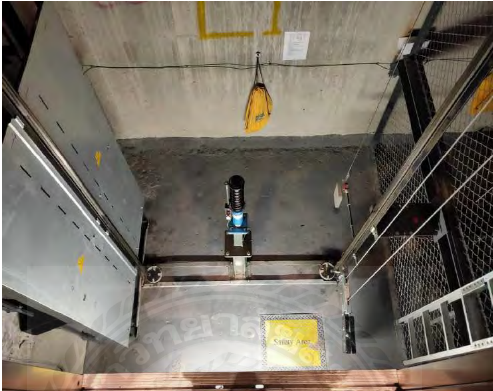
รูปที่ 2.12 กั้นบ่อลิฟต์ (Bottom Lift)
