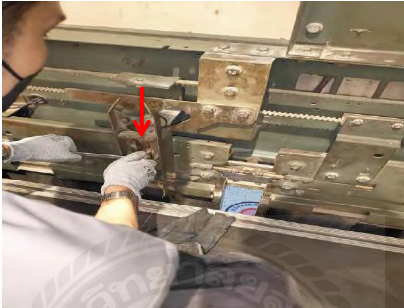
รูปที่ 3.34(A) ถอดน็อตยึดชุดแคมป์ประตูนำออก
