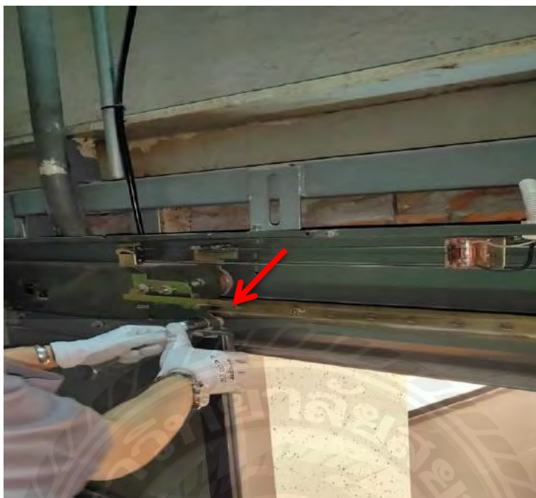
รูปที่ 3.15 การถอดลูกล้อ Uptouch ออก
