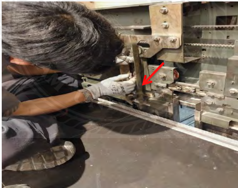
รูปที่ 3.35(B) ถอดน็อตยึดชุดแคมป์ประตูนำออก
