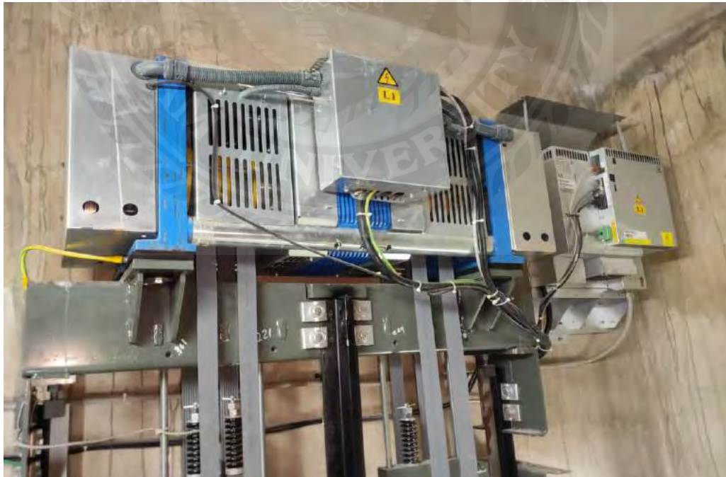
รูปที่ 2.7 มอเตอร์ขับเคลื่อนลิฟต์ (Motor machine)
