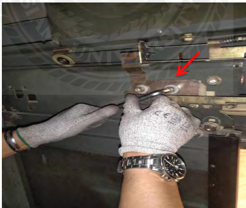
รูปที่ 3.7 การถอดชุด Doorlock ประตู
