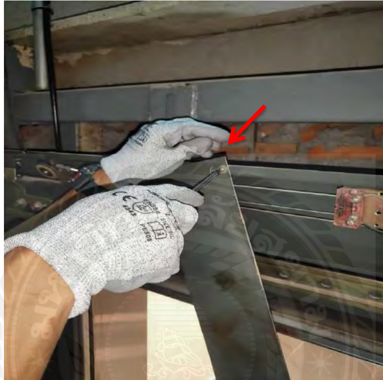
รูปที่ 3.14 การถอดแผงหน้าชุดประตูลิฟต์
