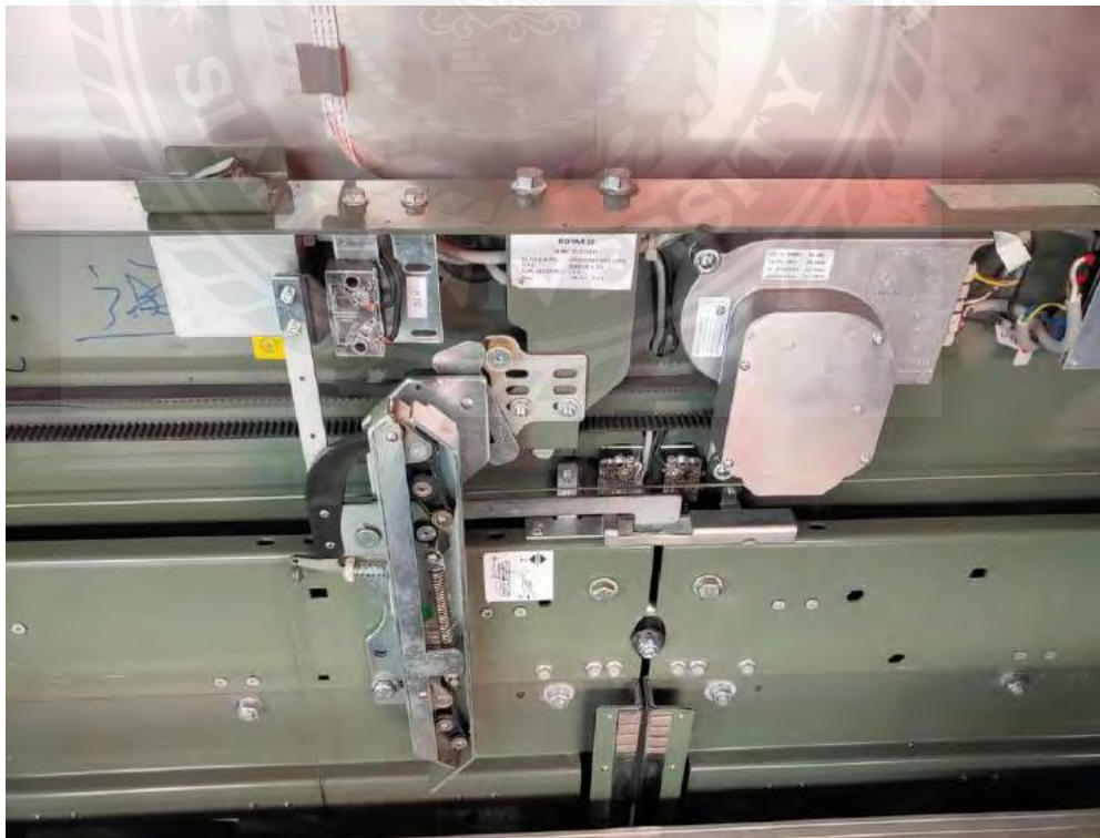
รูปที่ 2.13 ส่วนประกอบต่างๆของประตูลิฟต์
