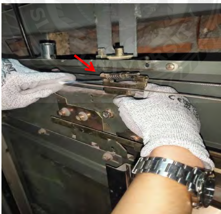
รูปที่ 3.16 ใช้เครื่องมือพิเศษถอดฐานตัวยึดสลิงออก
