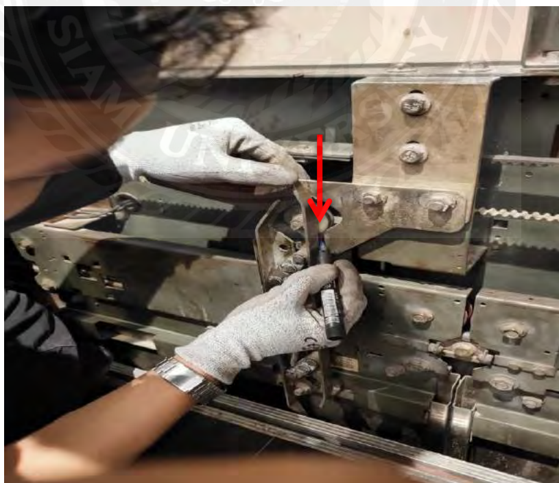
รูปที่ 3.22 นำเมจิกมาร์คระยะแคมป์ประตูดิมไว้ก่อนเปลี่ยน
