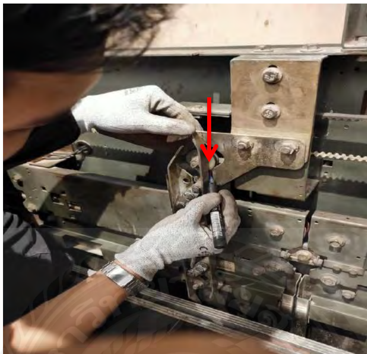
รูปที่ 3.32 นำเมจิกมาร์กกระยะแคมป์ประตูเดิมไว้ก่อนเปลี่ยน
