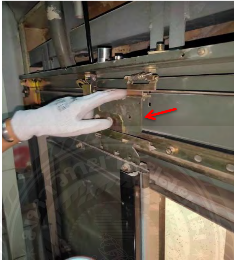
รูปที่ 3.19 หลังจากถอดลูกประตูดอกนำของใหม่มาเปลี่ยน
