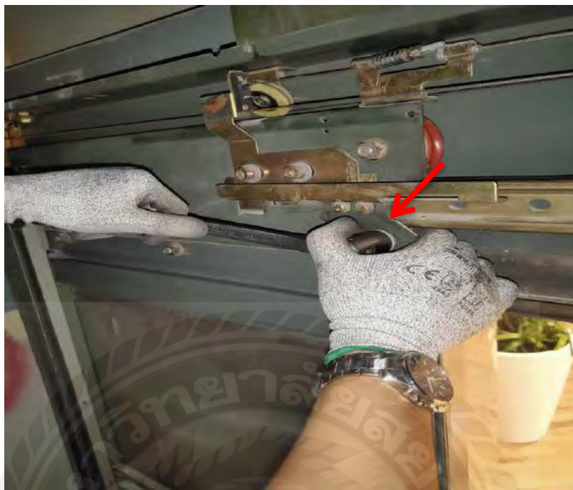
รูปที่ 3.6 การถอดลูกล้อ Uptouch ออก
