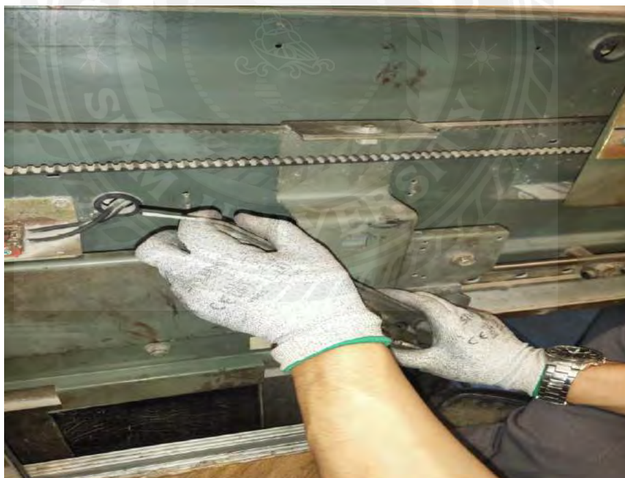
รูปที่ 3.28(B) ขั้นตอนการถอดน็อตยึดชุดแคมป์ประตู่และนำออกเปลี่ยนใหม่
