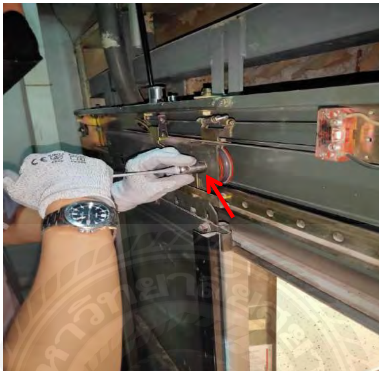
รูปที่ 3.17 นำเครื่องมือประแจเบอร์ 15 ถอดน็อตยึดลูกล้อออก
