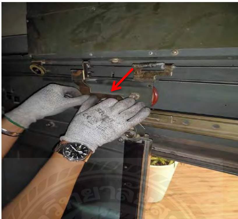
รูปที่ 3.8 การถอดชุด Doorlock ประตูและนำออก
