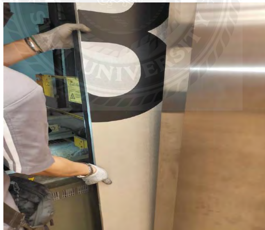
รูปที่ 3.11(B) การถอดยกบานประตูและนำออก
