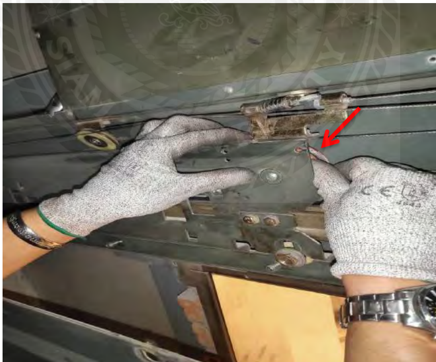
รูปที่ 3.13(B) การถอดลูกถ้วยประตูและนำออกเปลี่ยนใหม่
