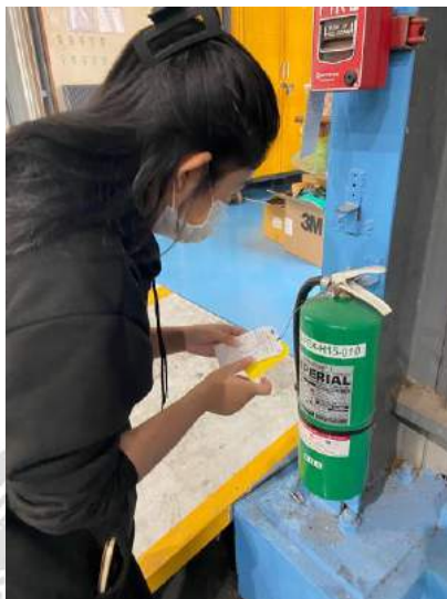
รูปที่ 3.3 การตรวจสอบเช็คสภาพถังดับเพลิง
