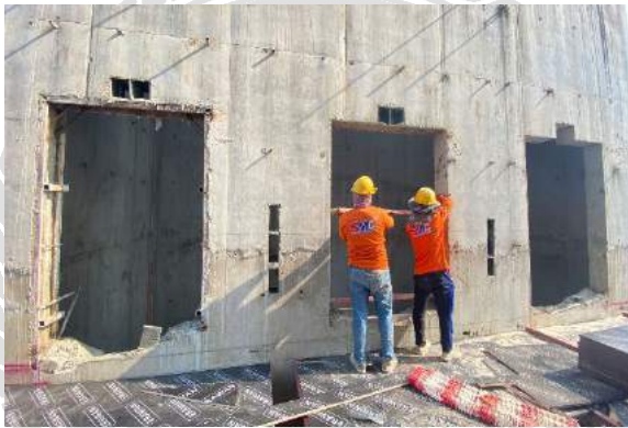
รูปที่ 3.3 ควบคุมดูแลความปลอดภัยในการจัดทำราวกันตกช่องลิฟต์
