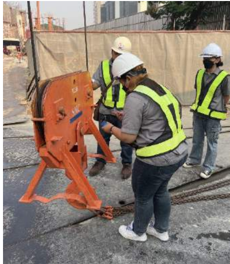
รูปที่ 3.4 ร่วมตรวจอุปกรณ์ Tower Crane
