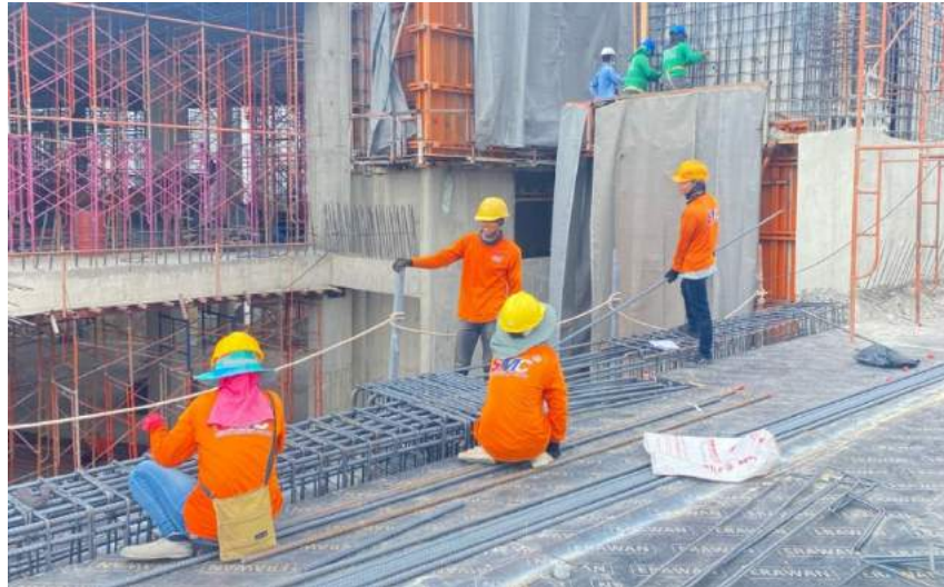
รูปที่ 4.12 การใสเหล็กเสริมโครงสร้าง
