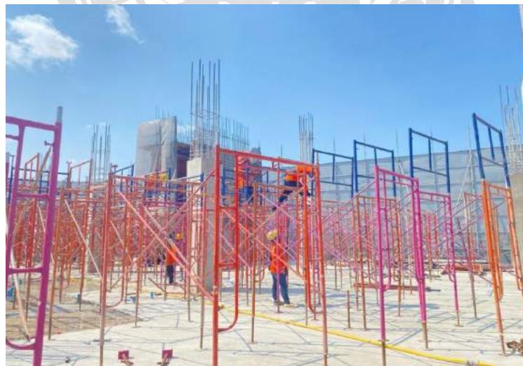
รูปที่ 4.5 การติดตั้งนั่งร้านรองรับน้ำหนักพื้น
