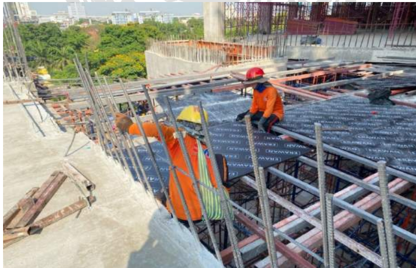
รูปที่ 4.9 การติดตั้งไม้แบบรองรับน้ำหนักคอนกรีตและคาน
