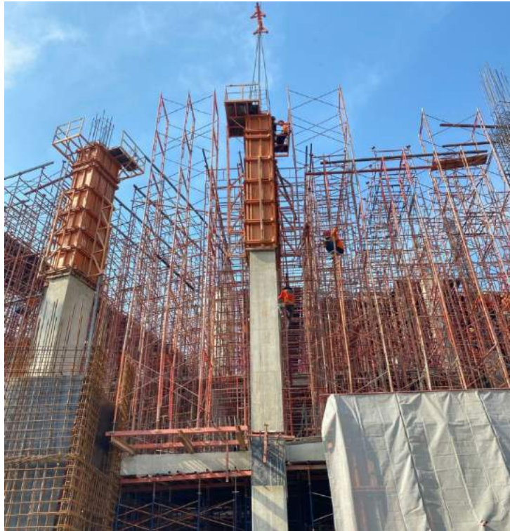
รูปที่ 4.21 การใช้ Tower Crane ยกถอดแบบเสาเหล็ก
