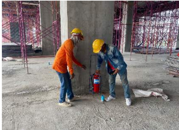
รูปที่ 3.2 ติดตั้งถังดับเพลิงภายในพื้นที่บริเวณอาคาร
