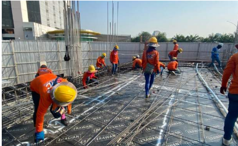
รูปที่ 4.10 การวางเหล็กข้ออ้อยเสริมพื้นคอนกรีต
