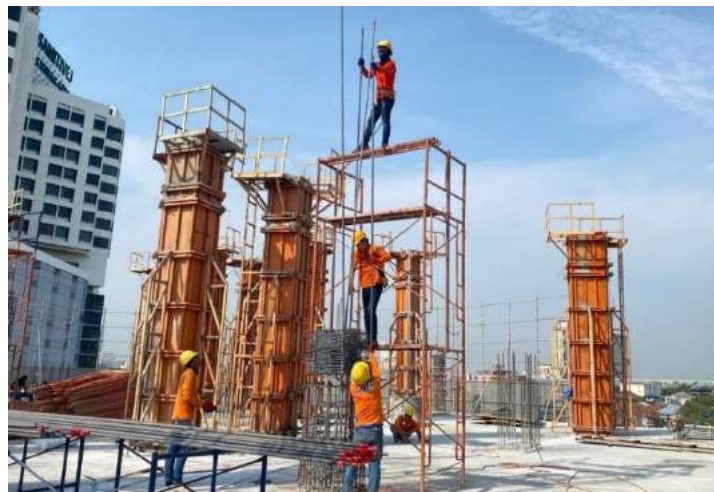
รูปที่ 4.14 การตั้งโครงเหล็กเสา
