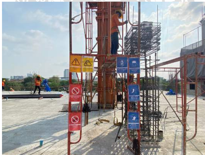
รูปที่ 3.9 ติดป้ายสัญลักษณ์ความปลอดภัยที่บันไดนั่งร้าน
