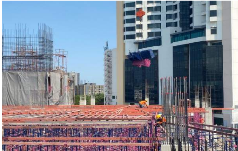
รูปที่ 4.2 การใช้ Tower Crane ขนย้ายอุปกรณ์นั่งร้าน
