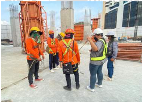
รูปที่ 3.1 ตรวจสอบความปลอดภัย Safety Full Body Harness และ Safety Belt
