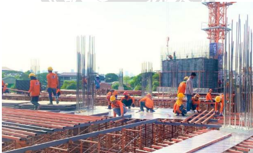
รูปที่ 4.7 การวางแบบโครงสร้างเหล็กกล่อง
