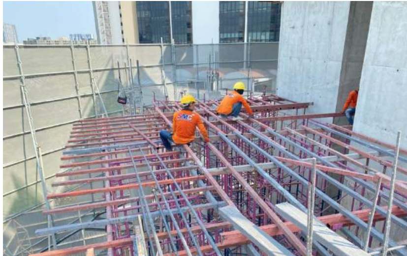
รูปที่ 4.6 การวางแบบโครงสร้างเหล็กกล่อง
