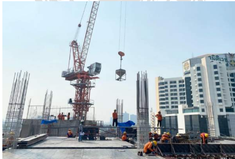
รูปที่ 4.3 การใช้ Tower Crane ขนย้ายพ็อคเก็ตปูน
