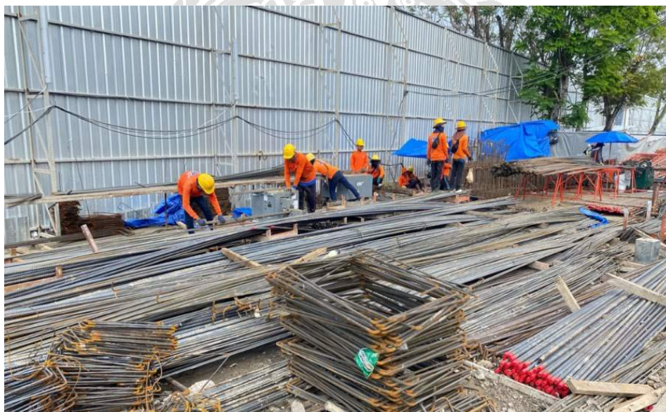
รูปที่ 4.1 การเตรียมเหล็กข้ออ้อย และเหล็กปลอก
