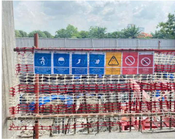
รูปที่ 3.10 ติดป้ายสัญลักษณ์ความปลอดภัยที่ราวกันตกขอบอาคาร
