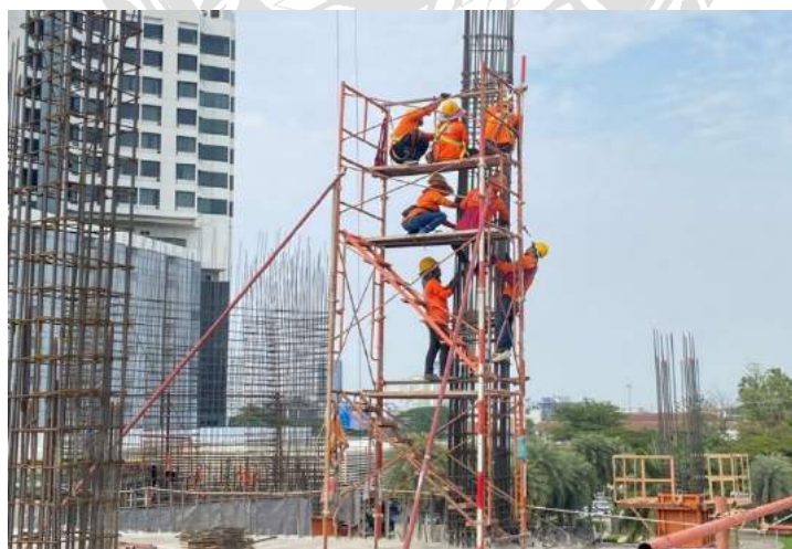
รูปที่ 4.15 การตั้งโครงเหล็กเสา
