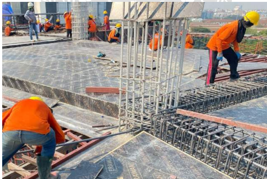
รูปที่ 4.13 การใสเหล็กเสริมโครงสร้าง
