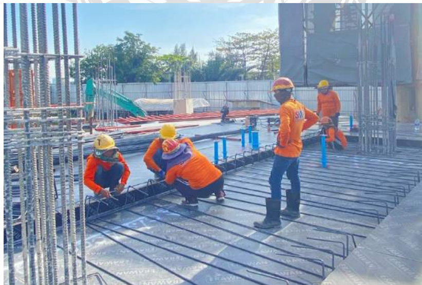
รูปที่ 4.11 การวางเหล็กข้ออ้อยเสริมพื้นคอนกรีต
