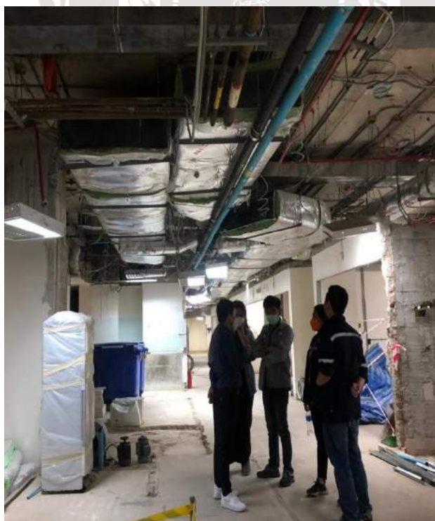
รูปที่ 3.2 พื้นที่ก่อสร้างในอาคาร
