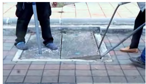
รูปที่ 1 การเปิดฝาท่อบำบัดน้ำเสียแบบดั้งเดิม
