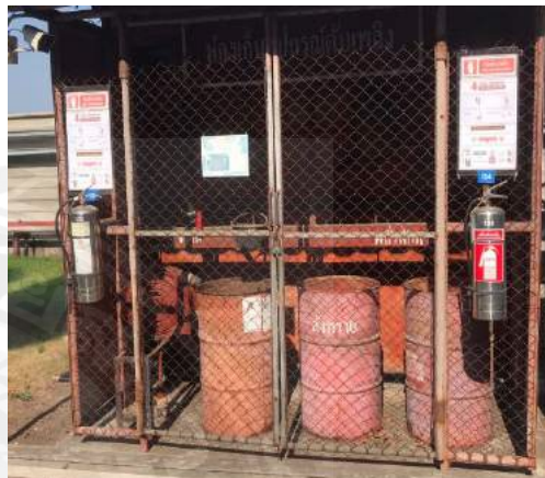
รูปที่ 2.6 ถังดับเพลิงชนิดโฟม
