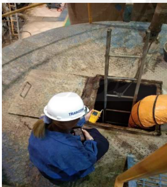
ตรวจวัดทางสุขศาสตร์อุตสาหกรรมภายในบริษัท (ตรวจวัดออกซิเจนในพื้นที่อับอากาศ)
