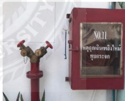
รูปที่ 4.10 สภาพตู้และสายดับเพลิงที่เป็นไปตามกฎหมาย
