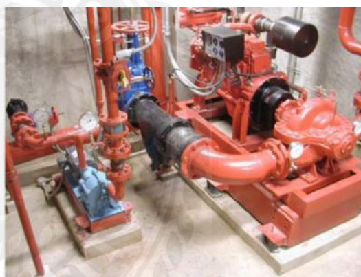
รูปที่ 4.2 เครื่องสูบน้ำดับเพลิงแบบแรงเหวี่ยงหนีศูนย์กลาง
