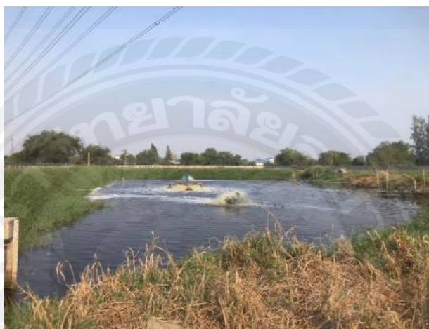
รูปที่ 2.2 บ่อน้ำการบำบัดด้วยระบบเอเอสที่ใช้กำจัดไนโตรเจนแบบธรรมดา เรียกว่าระบบ AO หรือ Anoxic-Oxic
