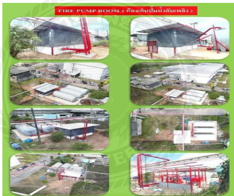
รูปที่ 4.4 สภาพห้องและการระบายอากาศภายในห้อง
