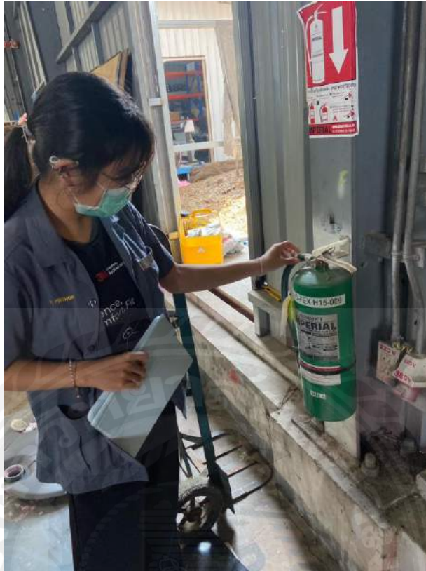
รูปตรวจเช็คถังดับเพลิงมือถือประจำเดือน
