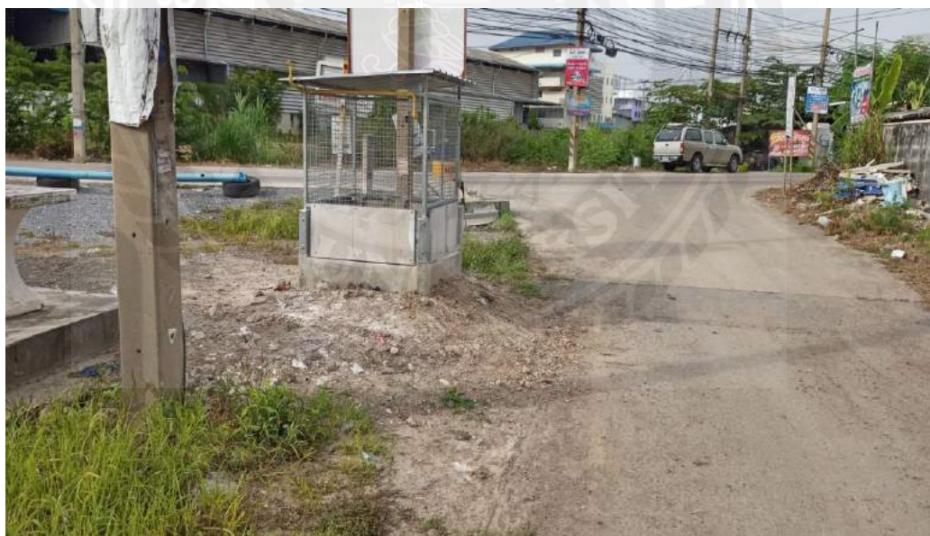
รูปที่ 3.7 ติดตั้งโครงในบ่อพักน้ำ
