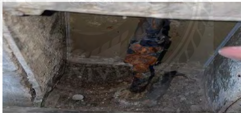
รูปภาพผนวก ที่ 64 จุดต่อประสานสักร้อยอยู่ในสภาพที่เก่าและมีสนิม
