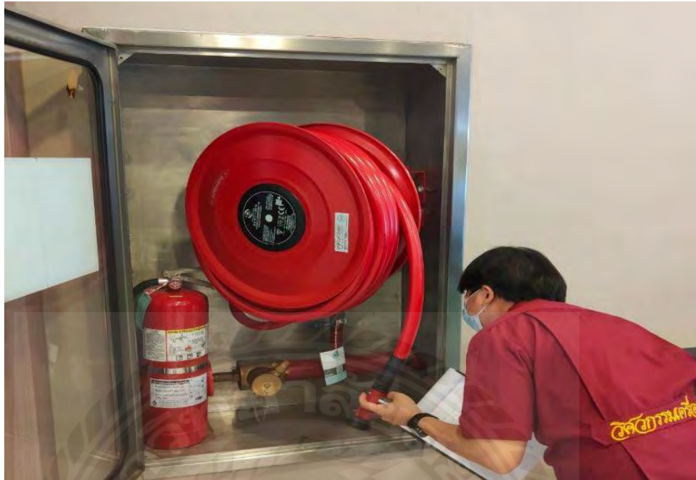
รูปที่ 3.13 ตรวจสอบหัวฉีดน้ำดับเพลิง
