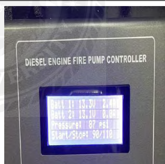
รูปภาพผนวก ที่ 57 ความดันน้ำอยู่ที่ 87 PSI
