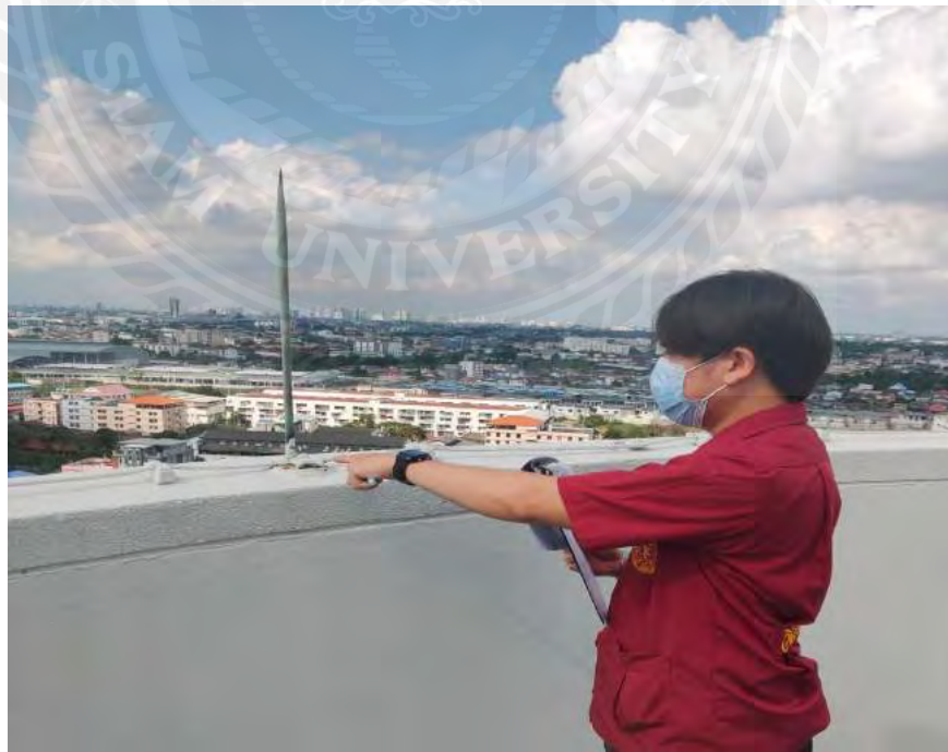
รูปที่ 3.14 ตรวจสอบระบบตัวนำล่อฟ้า
