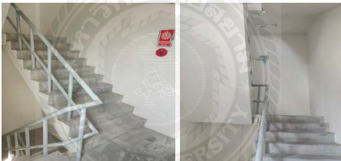
รูปที่ 3.5 ทางหนีไฟ
