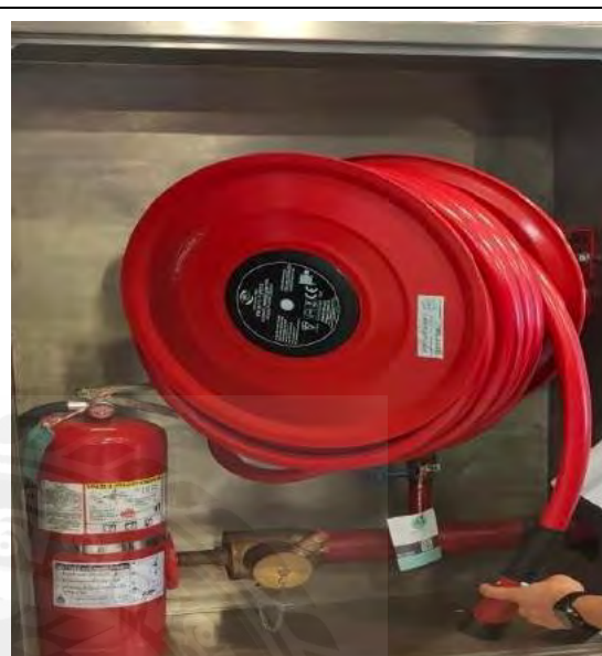
รูปภาพผนวก ที่ 55 ตรวจสอบสายลิดน้ำอยู่ในสภาพพร้อมใช้งาน
