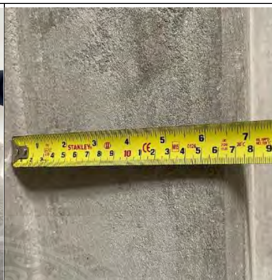
รูปภาพผนวก ที่ 13 วัดลูกตั้งบันได ที่ 1 สูง 18 ซม.
