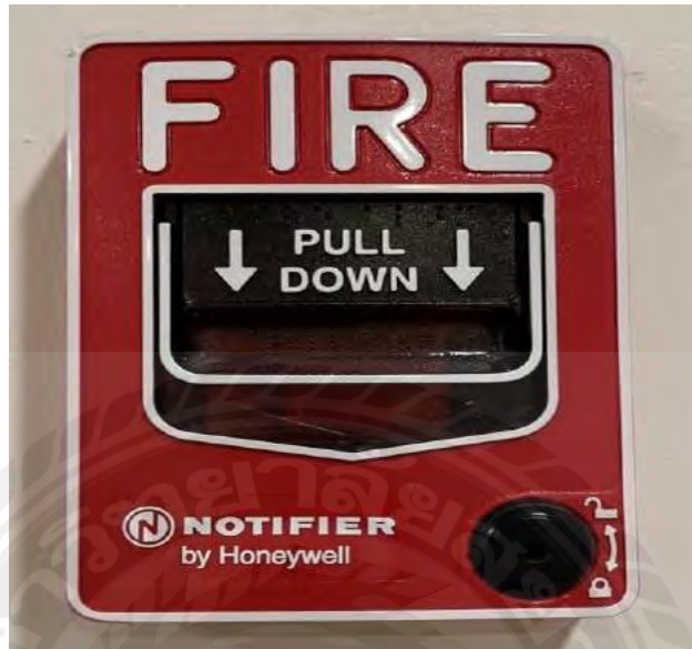
รูปที่ 3.8 ระบบสัญญาณแจ้งเหตุเพลิงไหม้ แบบ MANUAL STATION
