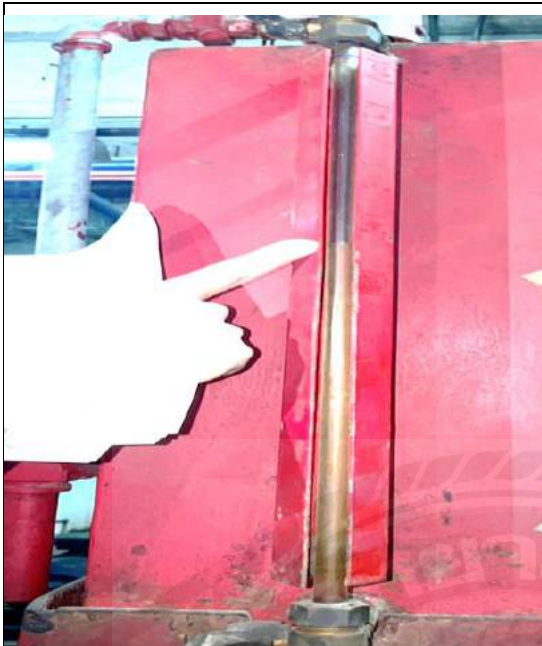
รูปภาพผนวก ที่ 58 ระดับน้ำมันเชื้อเพลิงอยู่ \frac{1}{2} ของถัง ต่ำกว่า เกณฑ์
