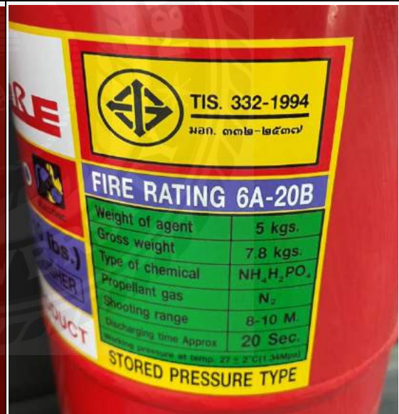
รูปภาพผนวก ที่ 49 ข้อมูลที่ติดของถังดับเพลิง ถังดับเพลิงมีขนาด บรรจุอยู่ที่ 5 KG
