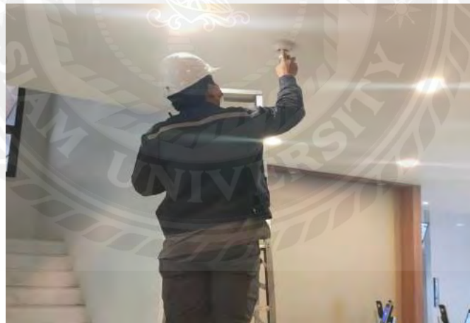
รูปภาพผนวก ที่ 45 ใช้อุปกรณ์สเปรย์ทดสอบเครื่องจับควัน นิดไปที่เครื่องเพื่อการทำงานจากระบบ ผลตรวจมีการ ใช้งานปกติ
