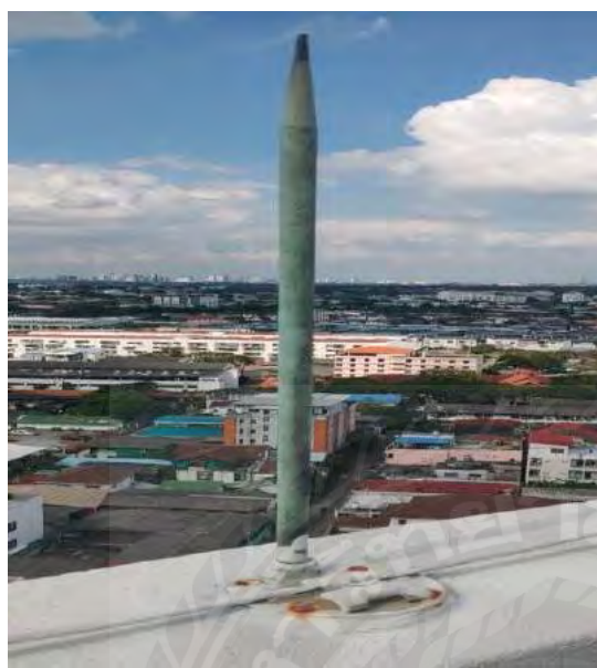
รูปภาพผนวก ที่ 63 สภาพของเสา ฐานเสาอยู่ในสภาพที่มีสนิม เล็กน้อยแต่ใช้งานได้ปกติ
