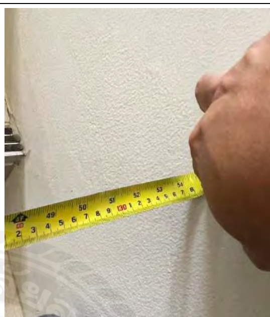
รูปภาพผนวก ที่ 17 วัดความกว้างบันไดที่ 2 ได้ 138 ซม.
