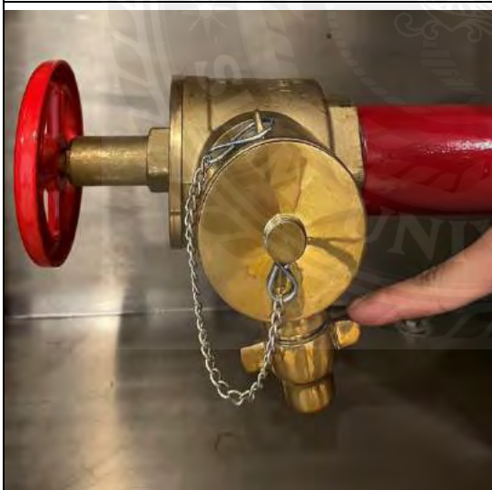
รูปภาพผนวก ที่ 56 ตรวจสอบหัวรับน้ำดับเพลิงอยู่ในสภาพพร้อม ใช้งาน
