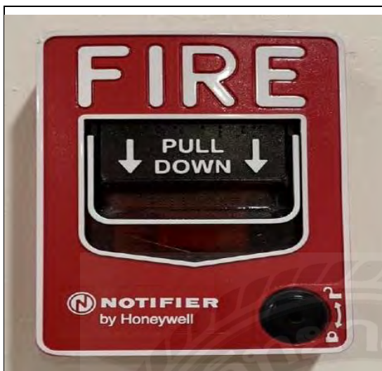
รูปภาพผนวก ที่ 39 อุปกรณ์ระบบสัญญาณแจ้งเหตุเพลิงไหม้แบบ Manual station
