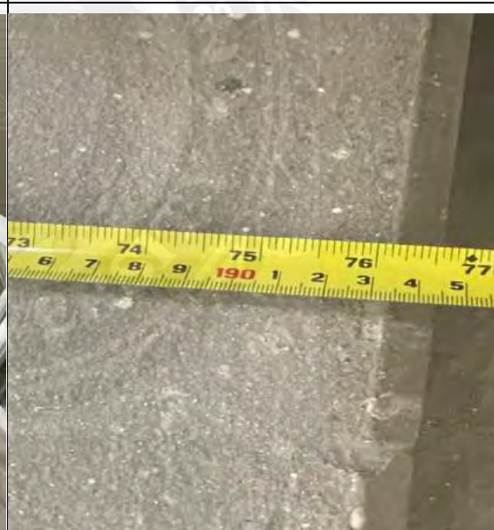
รูปภาพผนวก ที่ 15 วัดความกว้างชานพัก บันไดที่ 1 ได้ 194 ซม.
