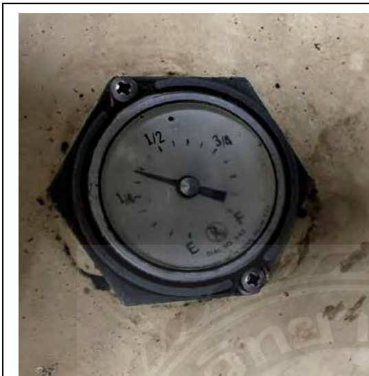
รูปภาพผนวก ที่ 33 ระดับน้ำมันเชื้อเพลิงเครื่องยนต์ อยู่ที่ 1/3 ของ ถึง ต่ำกว่าเกณฑ์
