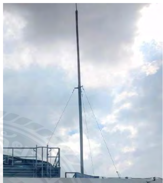
รูปภาพผนวก ที่ 64 รอยเชื่อมต่อและจุดยึดระหว่างสายสลิงและ เสา มีความตึงไม่หย่อน สภาพปกติ
