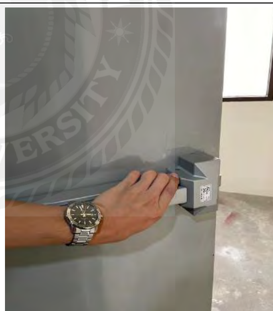
รูปภาพผนวก ที่ 4 อุปกรณ์เป็นชนิดแบบมือผลัก
