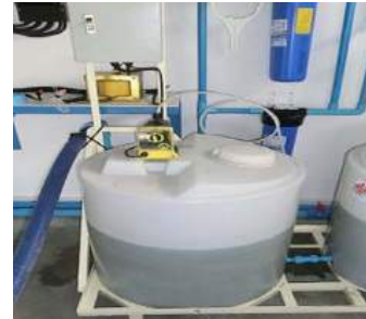
รูป 5 เครื่องจ่ายคลอรีน
