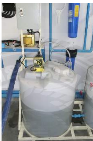
รูป 4.6 เครื่องจ่ายคลอรีนในการประปา
