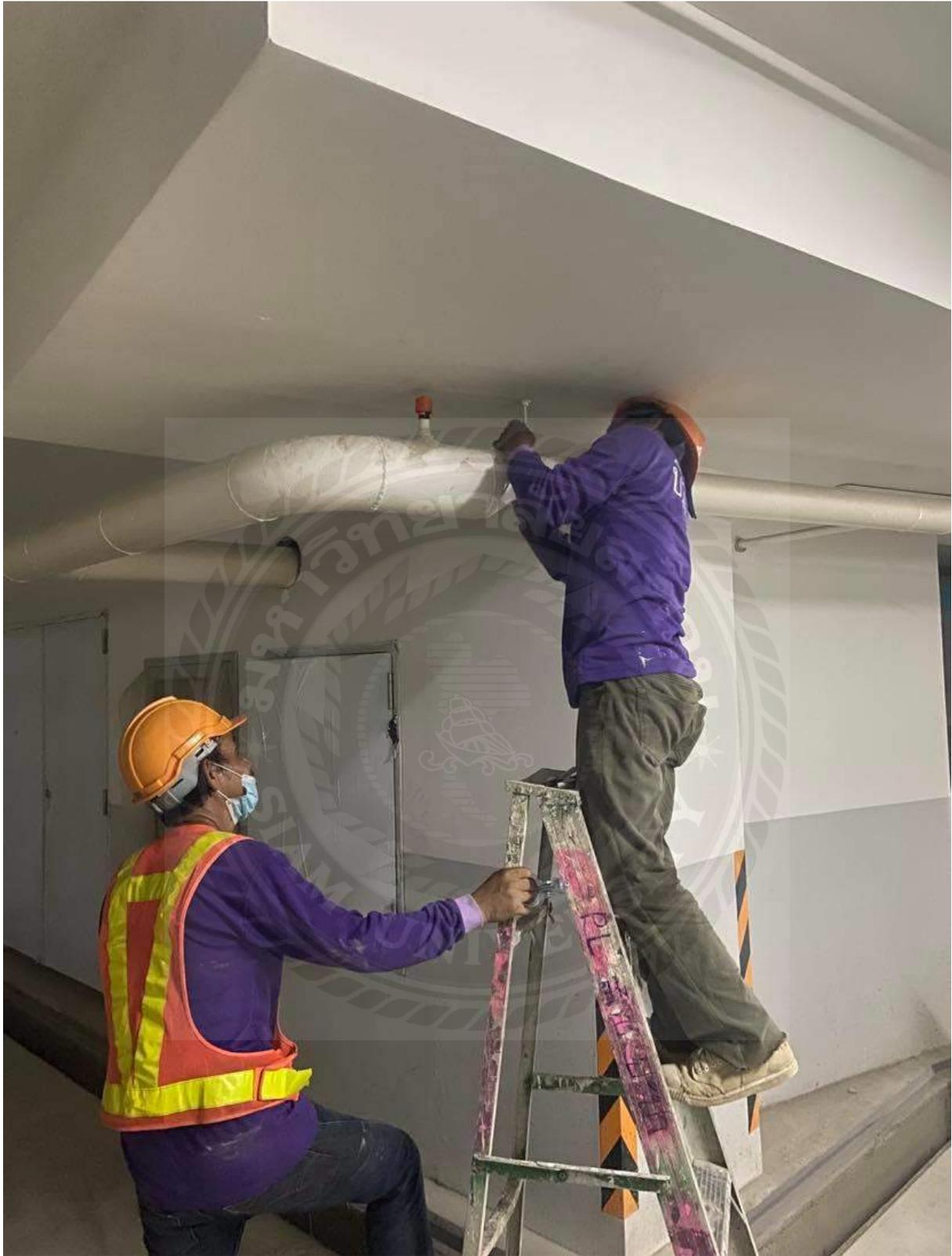
รูปที่ 1 การติดตั้งหัวกระจายน้ำและติดตั้งซัพพอร์ตท่อ
