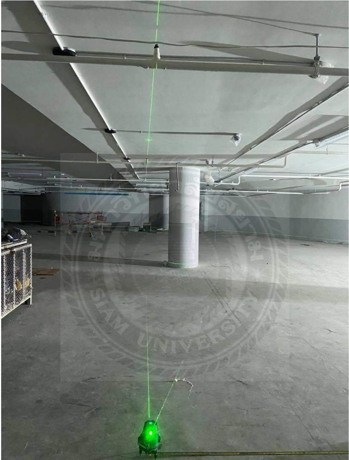
รูปที่ 3 ตรวจสอบเช็คระยะหัวกระจายน้ำด้วยเครื่องเลเซอร์วัดระดับแสง
