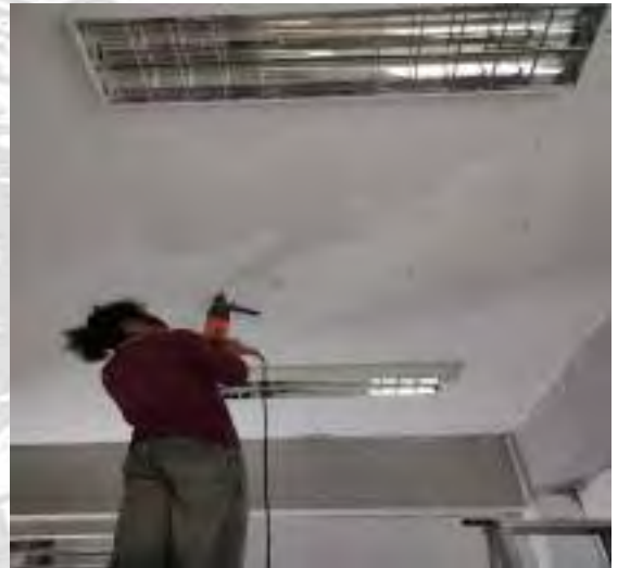
รูปที่ 4.34 รูปช่างกำลังติดตั้งโคมไฟ ชั้นที่ 1
