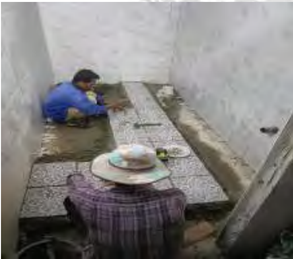
รูปที่ 4.12 งานฉาบพื้น - ผนัง (บริเวณห้องน้ำชั้นที่ 1)
