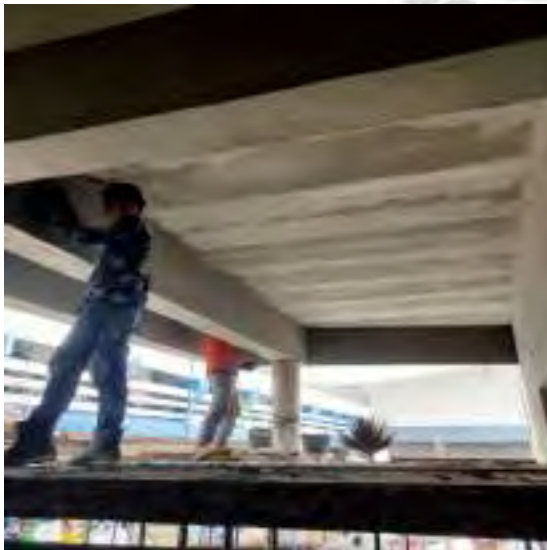
รูปที่ 4.20 รูปช่างกำลังฉาบปูนที่ผนังและกำแพง ชั้นที่ 1
