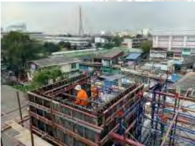
รูปที่ 4.4 ภาพหล่อคอนกรีตโครงสร้างลิฟต์ชั้นดาดฟ้า
