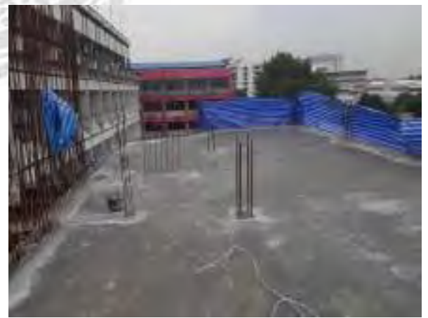
รูปที่ 4.3 ภาพหล่อคอนกรีตโครงสร้างพื้นชั้นดาดฟ้า
