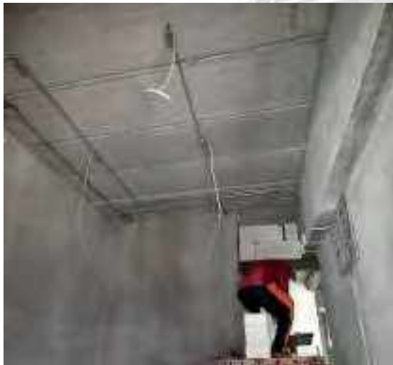
รูปที่ 4.31 รูปช่างกำลังทำการเดินท่อเหล็กพร้อมร้อยสายไฟฟ้า ชั้นที่ 1
