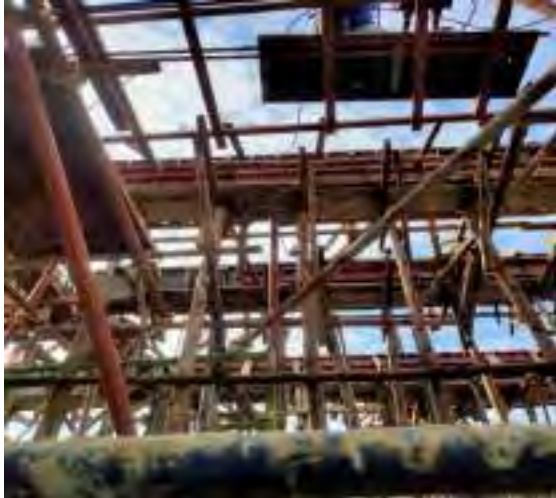
รูปที่ 4.27 ตั้งค้ำยันชั้น 4 และเข้าแบบคาน
