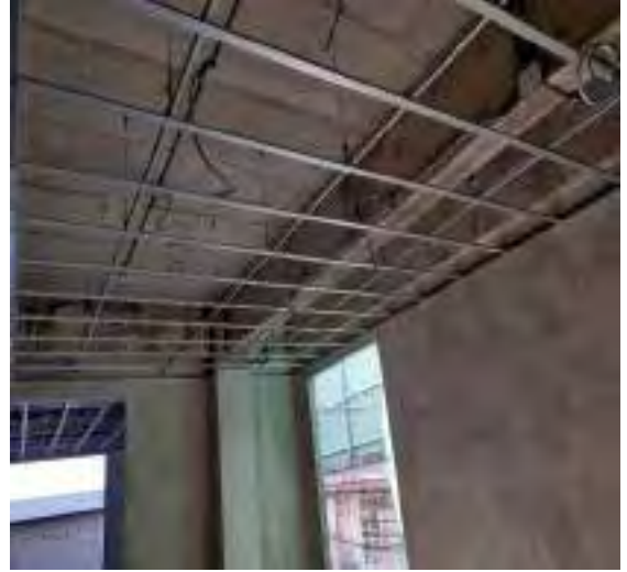
รูปที่ 4.33 รูปช่างกำลังติดตั้งโครงฝ้าชั้นที่ 1
