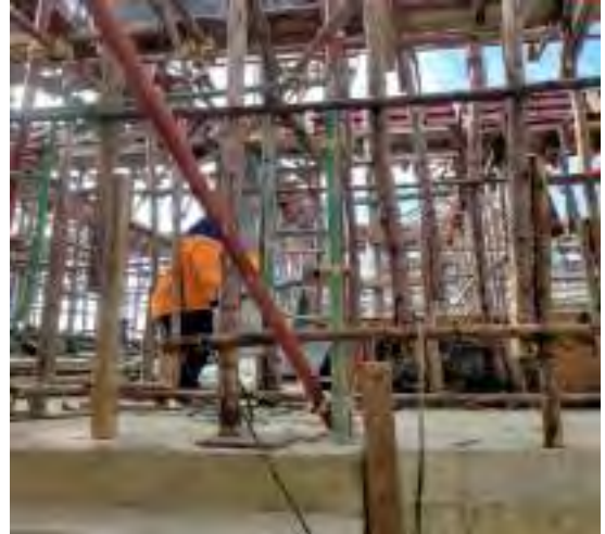
รูปที่ 4.27 ตั้งค้ำยันชั้น 4 และเข้าแบบคาน
