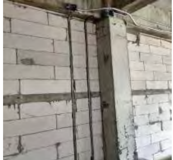
รูปที่ 4.32 รูปชั้นที่ 2 เดินท่อร้อยสายไฟฟ้าแต่ยังไม่ได้เดินสายไฟ
