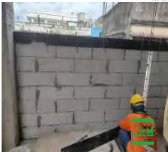
รูปที่ 4.23 รูปช่างกำลังก่อผนังชั้น 3 , ชั้น 4 และกำลังฉาบกำแพงชั้น 2
