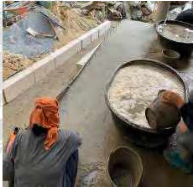
รูปที่ 4.15 งานฉิวพื้น - ผนัง (บริเวณบันไดทางขึ้นไปยังชั้นที่ 1)
