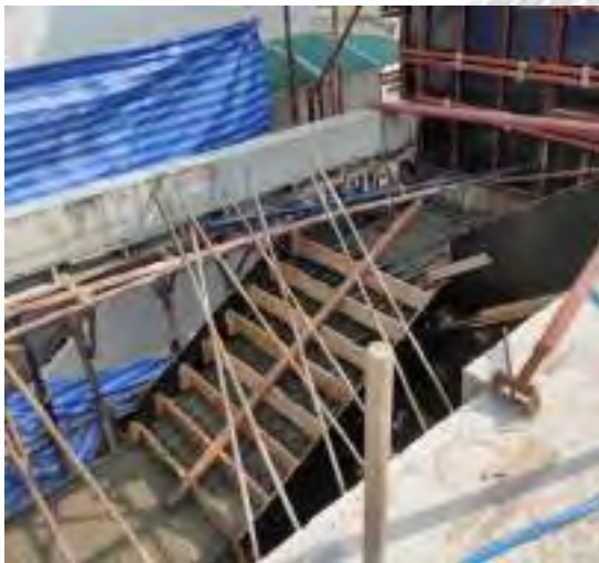
รูปที่ 4.22 รูปช่างกำลังทำการเทพูนเสาหลัก บันไดจากชั้น 3 ไปบันไดชั้น 4
