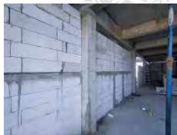
รูปที่ 4.6 ก่ออิฐผนังและติดตั้งวงกบประตู-หน้าต่างไม้ชั้นที่ 4
