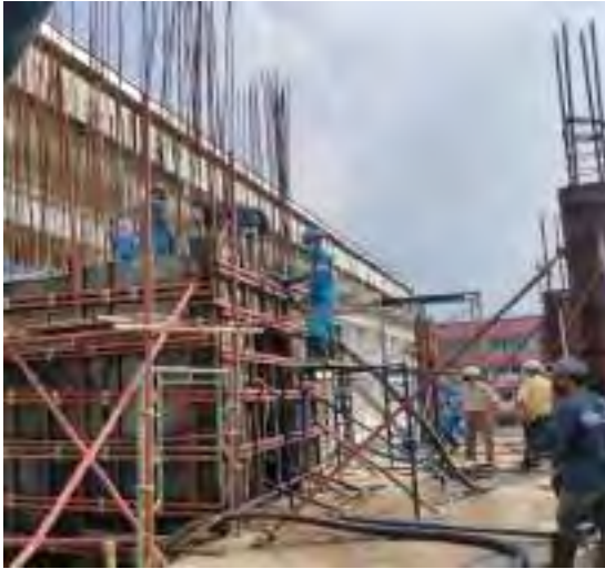
รูปที่ 4.21 รูปช่างกำลังทำการเทพูนผนังลิฟต์
