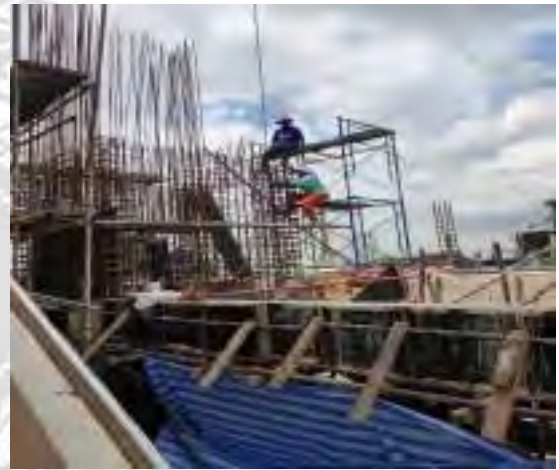
รูปที่ 4.19 รูปการผูกเหล็กเสาเพื่อไว้สำหรับเทพูน
