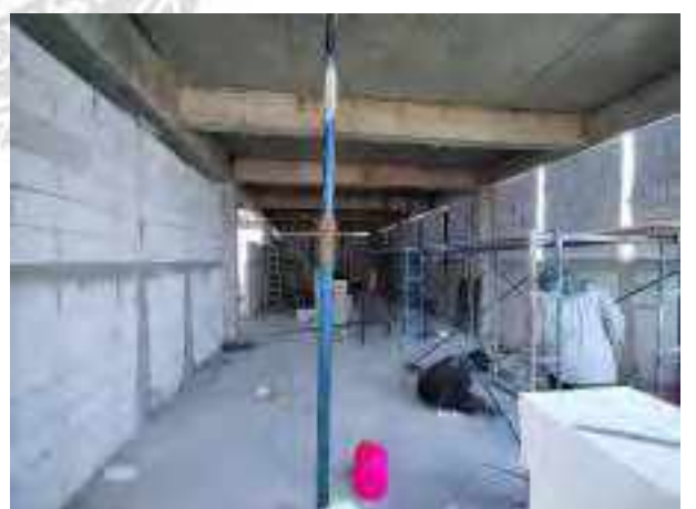
รูปที่ 4.6 ก่ออิฐผนังและติดตั้งวงกบประตู-หน้าต่างไม้ชั้นที่ 4
