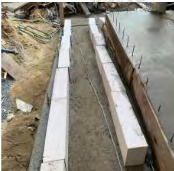
รูปที่ 4.15 งานฉิวพื้น - ผนัง (บริเวณบันไดทางขึ้นไปยังชั้นที่ 1)
