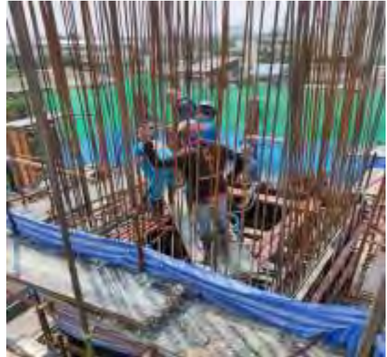
รูปที่ 4.21 รูปช่างกำลังทำการเทพูนผนังลิฟต์
