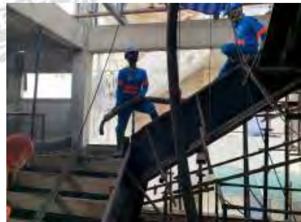
รูปที่ 4.5 ภาพหล่อคอนกรีตบันไดชั้นที่ 4 – ดาดฟ้า
