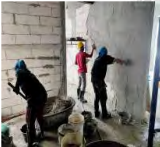
รูปที่ 4.28 รูปช่างกำลังฉาบปูนผนังภายในอาคาร ชั้น 2 และ ชั้น 3
