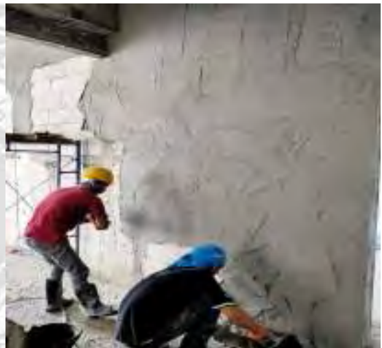
รูปที่ 4.28 รูปช่างกำลังฉาบปูนผนังภายในอาคาร ชั้น 2 และ ชั้น 3
