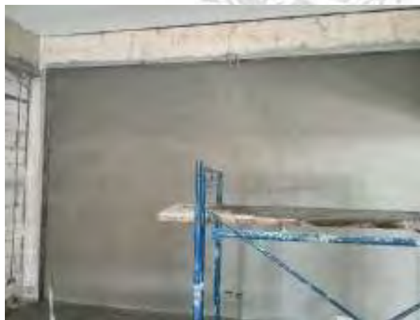
รูปที่ 4.7 ฉาบปูนผนังชั้น 2
