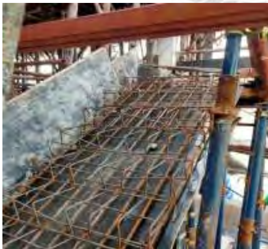
รูปที่ 4.29 รูปวางเหล็กพื้นชั้นดาดฟ้าและบันไดชั้นบน
