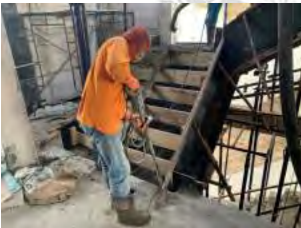
รูปที่ 4.5 ภาพหล่อคอนกรีตบันไดชั้นที่ 4 – ดาดฟ้า
