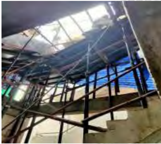
รูปที่ 4.19 รูปการผูกเหล็กเสาเพื่อไว้สำหรับเทพูน
