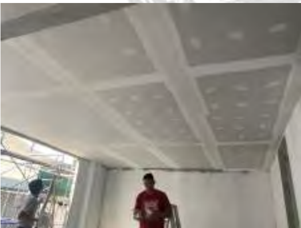
รูปที่ 4.10 งานฝ้าเพดานชั้นที่ 1
