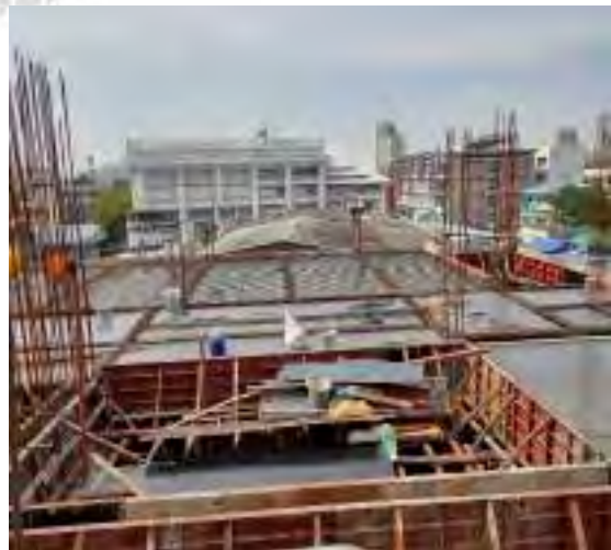
รูปที่ 4.29 รูปวางเหล็กพื้นชั้นดาดฟ้าและบันไดชั้นบน
