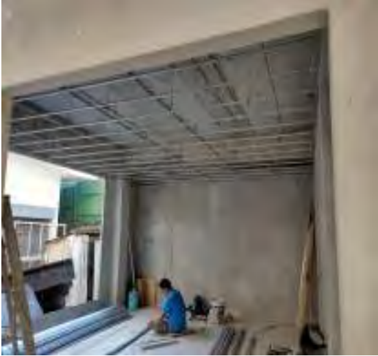
รูปที่ 4.33 รูปช่างกำลังติดตั้งโครงฝ้าชั้นที่ 1
