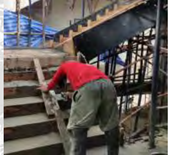
รูปที่ 4.22 รูปช่างกำลังทำการเทพูนเสาหลัก บันไดจากชั้น 3 ไปบันไดชั้น 4
