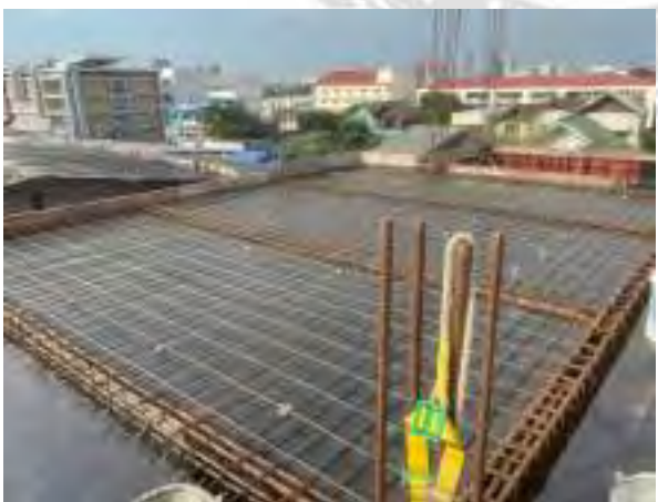
รูปที่ 4.3 ภาพหล่อคอนกรีตโครงสร้างพื้นชั้นดาดฟ้า
