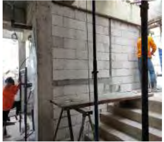
รูปที่ 4.24 รูปช่างกำลังทำการฉาบและก่อผนังห้องน้ำ ชั้น 3
