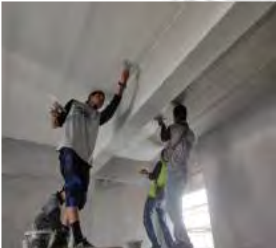
รูปที่ 4.26 รูปช่างกำลังทำการสกิน โท๊คหรือเรียกอีกอย่างว่า ฉาบผิวเรียบแบบบางๆ บริเวณชั้น 2 และ ชั้น 3
