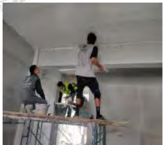
รูปที่ 4.26 รูปช่างกำลังทำการสกิน โท๊คหรือเรียกอีกอย่างว่า ฉาบผิวเรียบแบบบางๆ บริเวณชั้น 2 และ ชั้น 3
