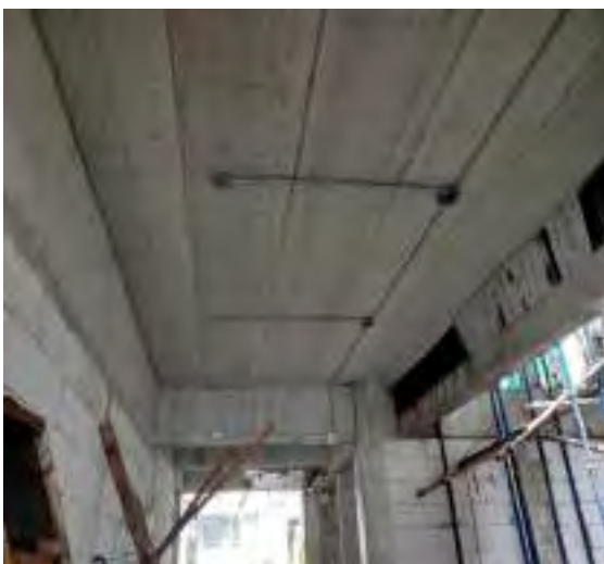
รูปที่ 4.32 รูปชั้นที่ 2 เดินท่อร้อยสายไฟฟ้าแต่ยังไม่ได้เดินสายไฟ
