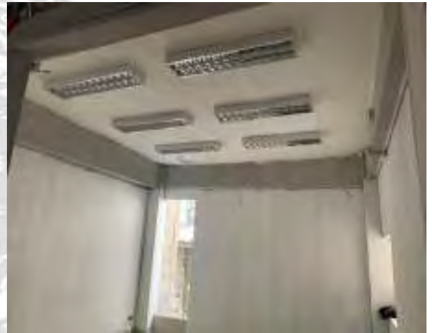
รูปที่ 4.17 งานติดตั้งดวงโคมชั้นที่ 1
