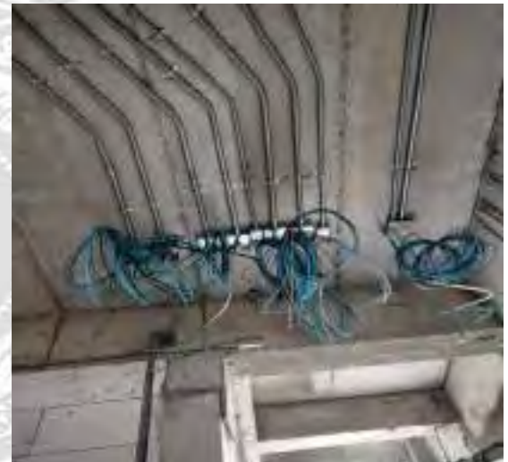
รูปที่ 4.31 รูปช่างกำลังทำการเดินท่อเหล็กพร้อมร้อยสายไฟฟ้า ชั้นที่ 1
