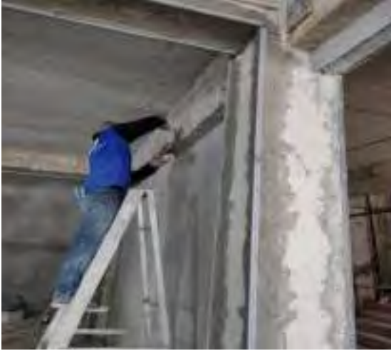
รูปที่ 4.24 รูปช่างกำลังทำการฉาบและก่อผนังห้องน้ำ ชั้น 3
