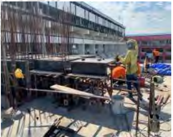
รูปที่ 4.4 ภาพหล่อคอนกรีตโครงสร้างลิฟต์ชั้นดาดฟ้า
