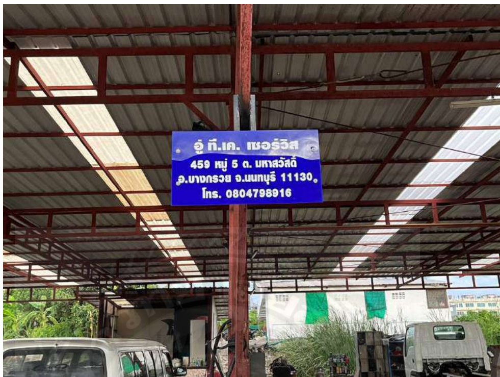
รูปที่ 3.2 สถานที่ปฏิบัติงาน
