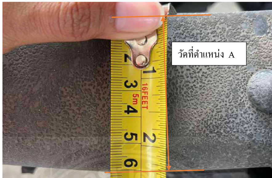
รูปที่ 4.24 ตำแหน่งการวัดโครงสร้างซีเมนต์ตำแหน่ง A ที่ SECTION B
