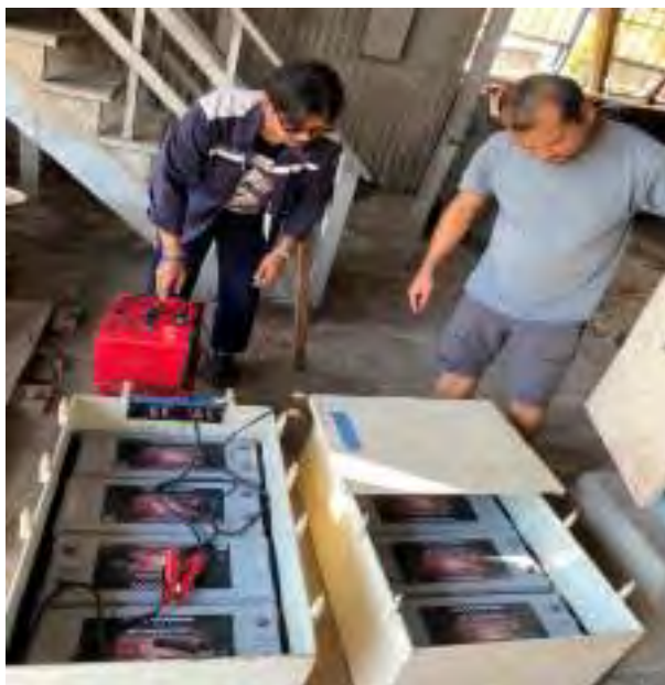
รูป 4.6 ตรวจสอบแบตเตอรี่และเปลี่ยนแบตเตอรี่ใหม่
