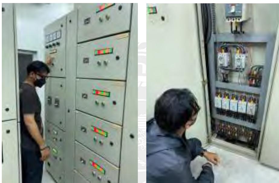
รูป 4.5 ตรวจเช็คระบบไฟฟ้าและไฟแสดงสถานะ
