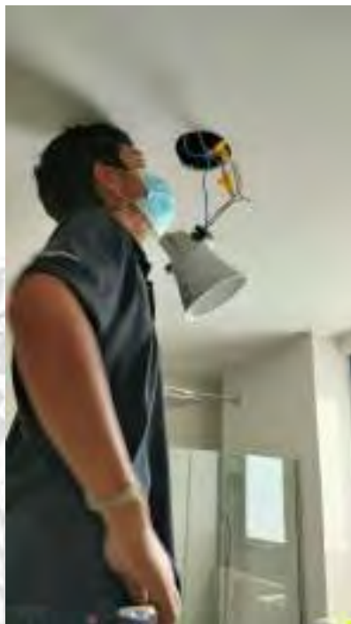
รูปที่ 4.39 การติดตั้งสายไฟที่โคมไฟ
