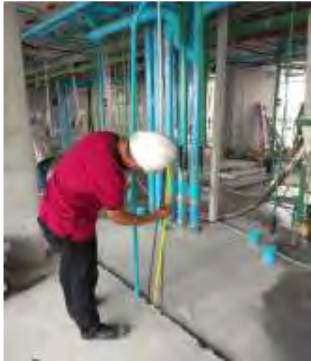
รูปที่ 4.7 ตรวจระยะความสูงของการติดตั้งบล็อก
