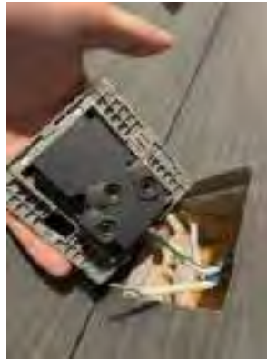
รูปที่ 4.33 การต่อปลายสายเข้ากับเต้ารับ
