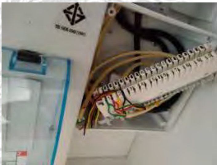
รูปที่ 4.25 การเข้าสายเมนที่บนหัวช่องที่ 1 เข้าสายเขียว แดง เหลือง ดำ ตามลำดับ
