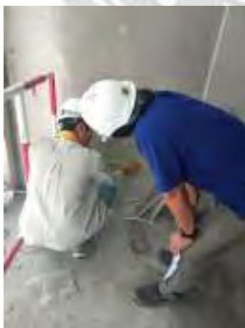
รูปที่ 4.11 ตรวจสอบระยะโดยใช้ตลับเมตร
