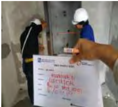
รูปที่ 4.13 ตรวจสอบระยะบล็อก
