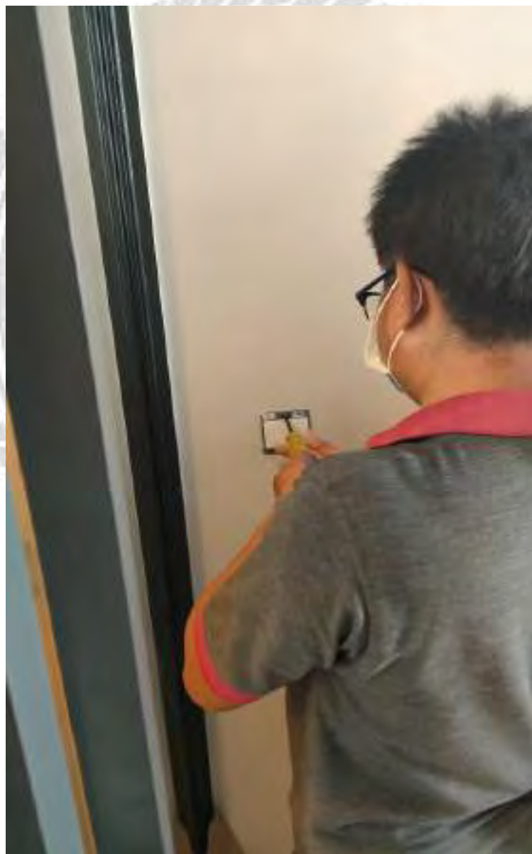
รูปที่ 4.38 ติดตั้งสวิตช์ไฟ
