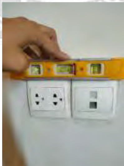
รูปที่ 4.35 การตรวจสอบระดับของเต้ารับ
