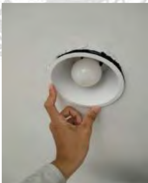
รูปที่ 4.40 การยึดติดโคมไฟเข้ากับฝ้า
