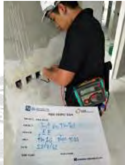
รูปที่ 4.21 การตรวจสอบสายโทรศัพท์ห้องนั่งเล่น รูปที่ 4.22 การตรวจสอบสายโทรศัพท์ห้องนอน
