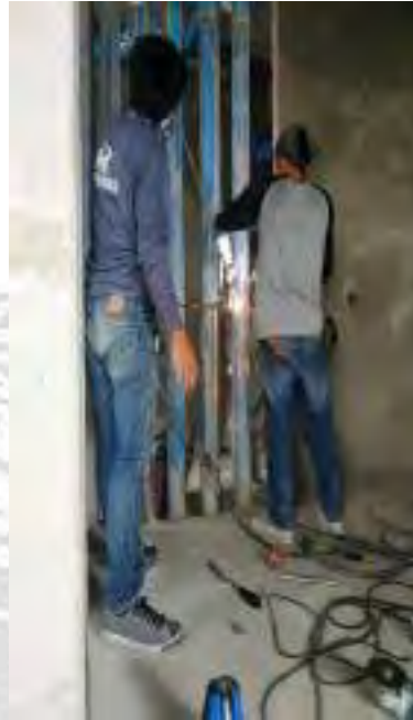
รูปที่ 4.5 ขณะเชื่อมบล็อกกับเหล็ก
