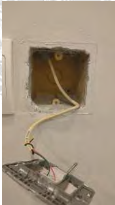
รูปที่ 4.28 การตรวจสอบสายโทรศัพท์
