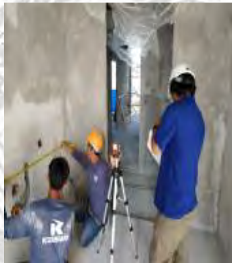
รูปที่ 4.10 ใช้เลเซอร์วัดระดับในการตรวจสอบ
