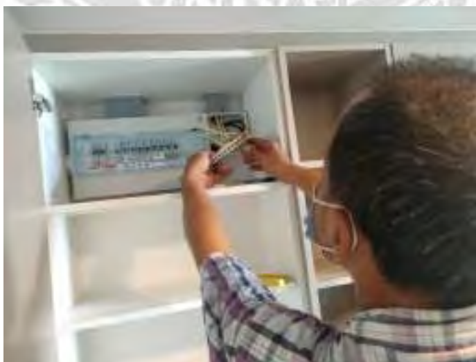
รูปที่ 4.26 เข้าสายในเทอร์มินอลแล้วใส่เข้ายัดที่ตู้
