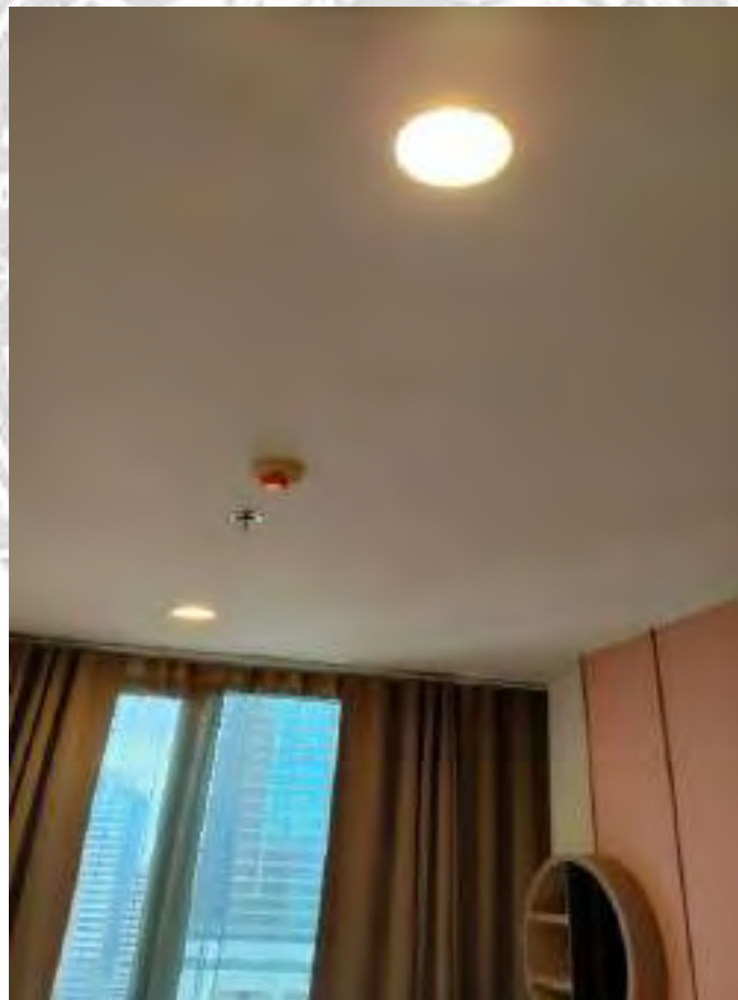
รูปที่ 4.42 ตรวจสอบโคมไฟบริเวณห้องนอน
