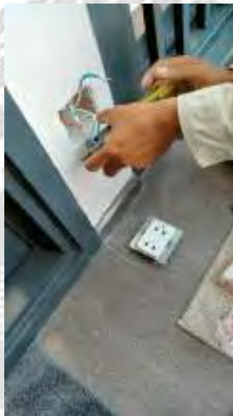
รูปที่ 4.34 การติดตั้งเต้ารับเข้ากับบล็อก
