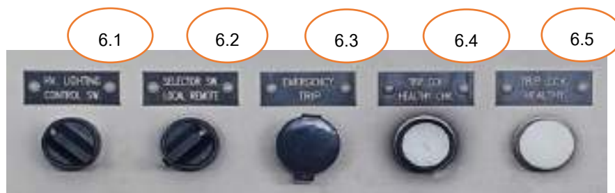
รูปที่ 2.24 สวิตช์ควบคุม (Selector) ต่างๆ และ ปุ่มเช็ค TRIP HEALTHY
