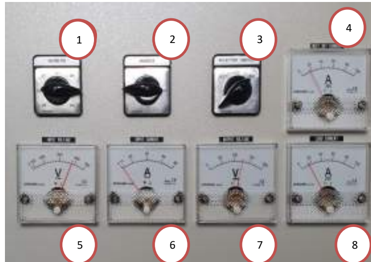
รูปที่ 2.43 ชุดการแสดงผลค่าแรงดัน/กระแสไฟฟ้า ของ Battery Charger
