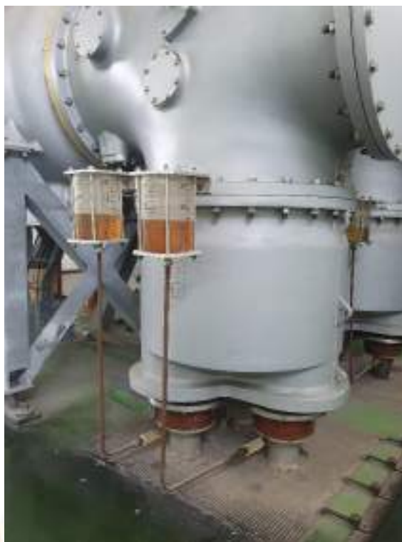
รูปที่ 2.4 ชุดน้ำมันหล่อลื่น สายเคเบิล ด้านแรงสูง
