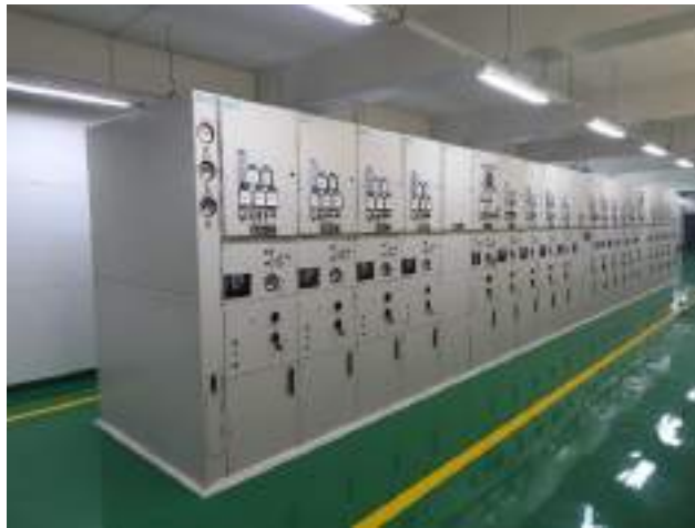
รูปที่ 2.14 ชุดสวิตช์เกียร์แรงดันปานกลาง
