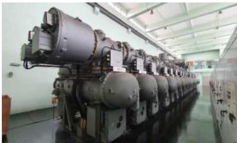
รูปที่ 2.1 สวิตช์เกียร์ไฟฟ้าแรงสูง
