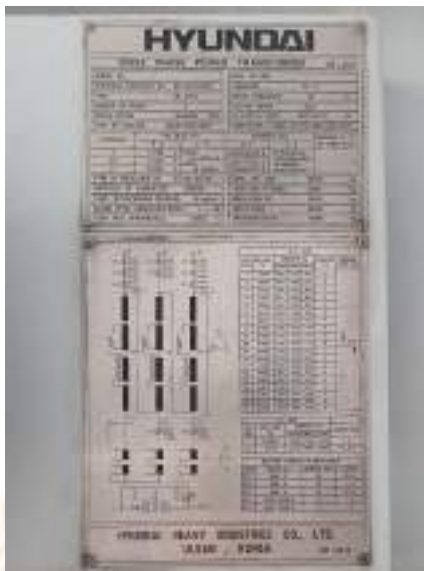
รูปที่ 2.33 ป้าย NAME PLATE ของหม้อแปลงไฟฟ้า TR2
