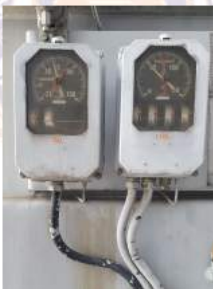
รูปที่ 2.32 เกจวัดอุณหภูมิของ ขดลวดหม้อแปลง และ น้ำมันหม้อแปลง
