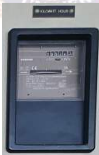
รูปที่ 2.21 กิโลวัตต์ฮาวล์มิเตอร์ ที่ใช้วัดค่าการใช้กำลังไฟฟ้า
