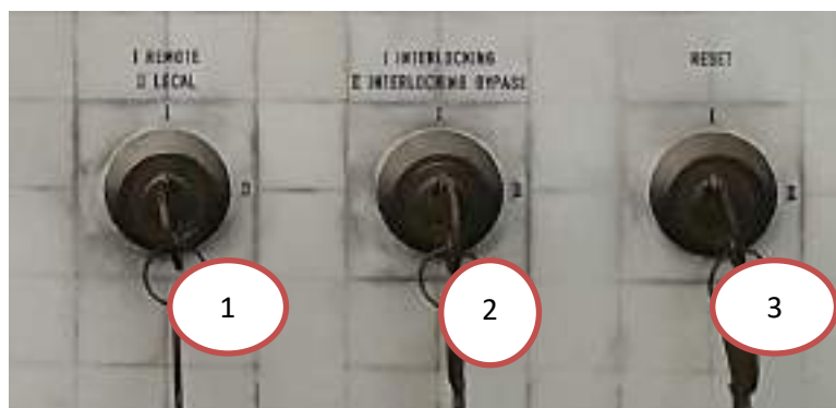
รูปที่ 2.12 สถานะเลือกควบคุม รวมถึงการ MANUAL RESET
