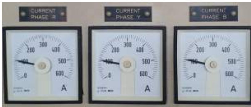
รูปที่ 2.22 แอมป์มิเตอร์ใช้วัดค่ากระแสไฟฟ้าของเฟส R-Y-B
