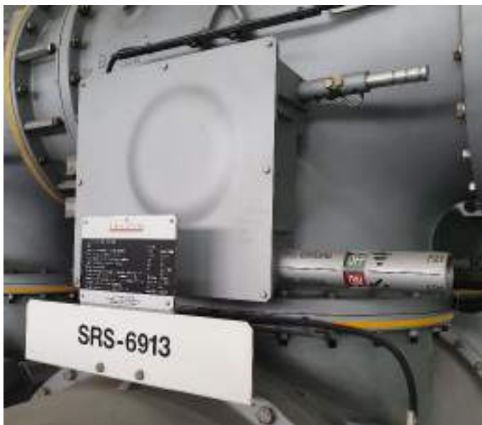
รูปที่ 2.2 อุปกรณ์ Disconnecting Switch/Earthing Switch ใน Switchgear High Voltage
