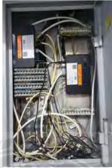
รูปที่ 3.7 ตัดถ่ายจากเลขหมายทองแดงมาเป็นเลขหมาย IP-phone
