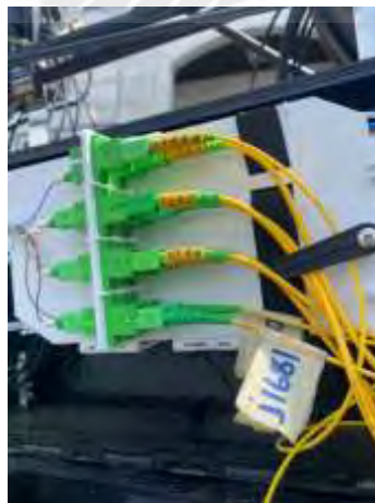
รูปที่ 4.4 ตู้พักสาย SDP
