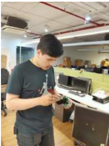
รูปที่ 4.4 การทดสอบ Smoke Detector
