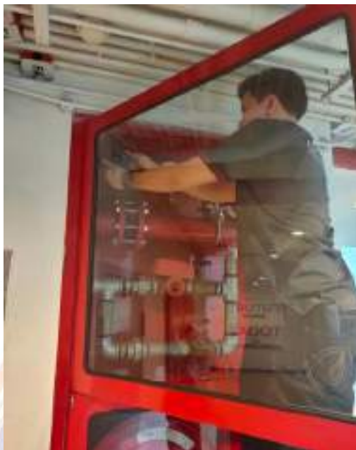
รูปที่ 4.8 ทดสอบ Water Flow switch
