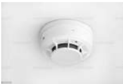
รูปที่ 2.7 Smoke Detector
