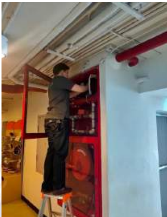
รูปที่ 4.12 ทดสอบ Supervisory Switch
