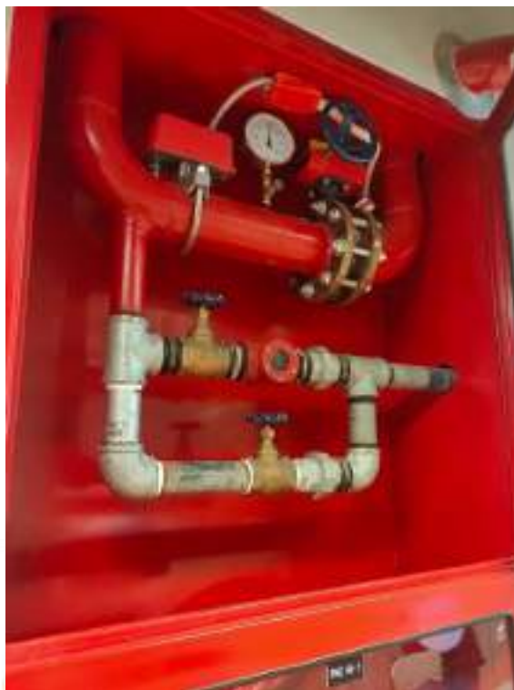
รูปที่ 4.10 ทดสอบ Water Flow switch
