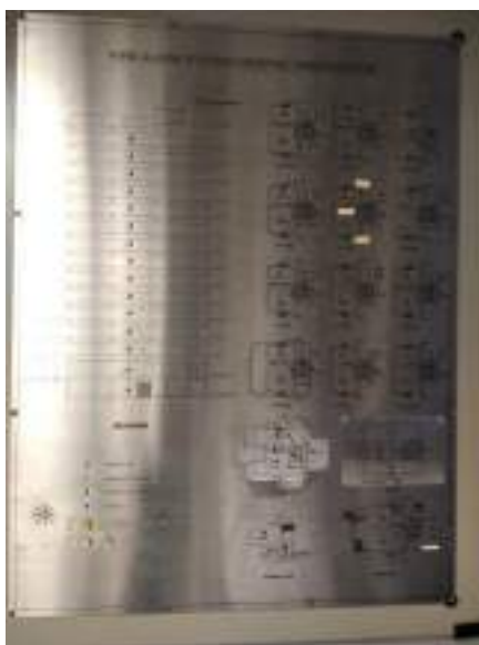
รูปที่ 2.12 Graphic Annunciator
