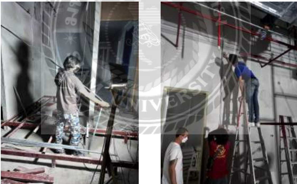
รูปที่ 4.1 การเดินท่อแบบฝังผนังและเดินลอยเหนือฝ้า
