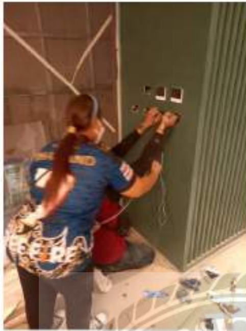
รูปที่ 4.5 การติดตั้งRoom thermo(อุปกรณ์ควบคุมแอร์)
