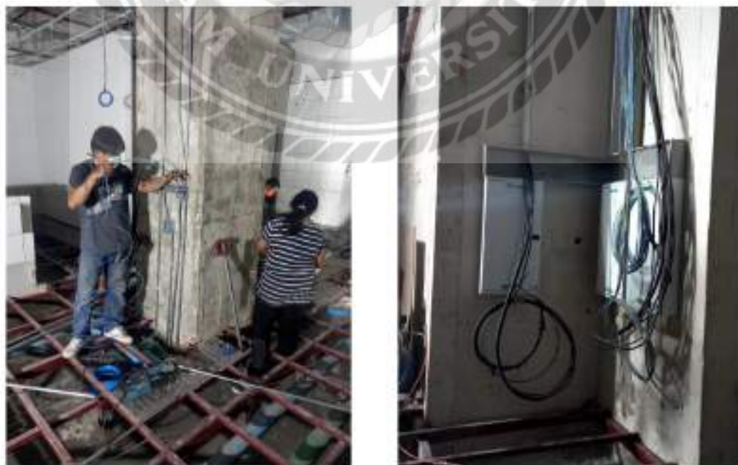
รูปที่ 4.3 การเดินสายเมนไฟและสายไฟจ่ายตามจุด
