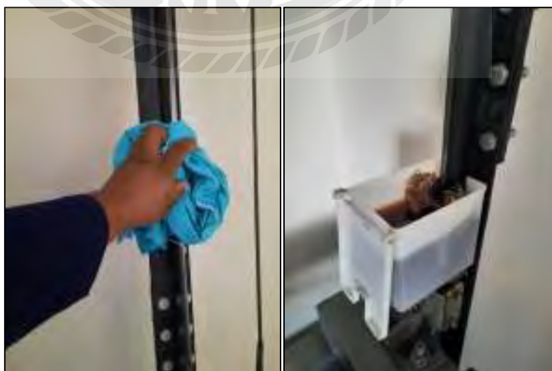
รูปที่ 4.15 เช็คราง และเติมน้ำมันราง
