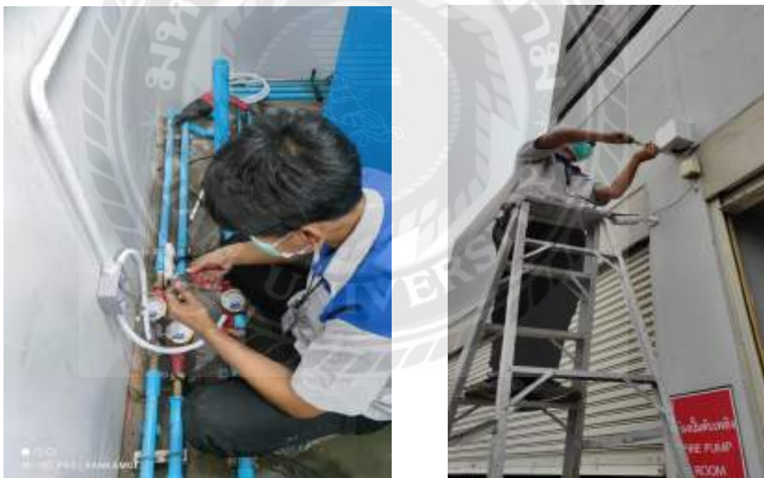
รูปที่ 4.3 เดินสายมิเตอร์น้ำแบบพัลส์ไปยังกล่องคอนโทรล
