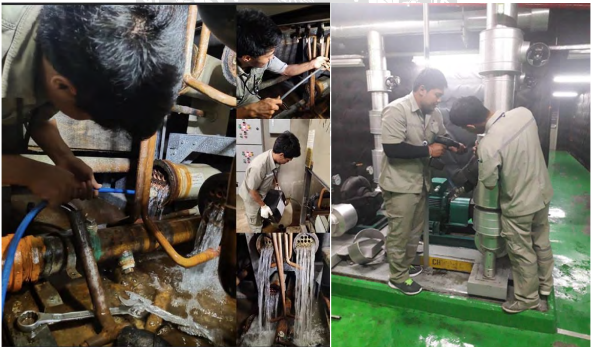
รูปที่ 2 การทำความสะอาดท่อทิวของซิลเลอร์ หรือ แยกทิว
