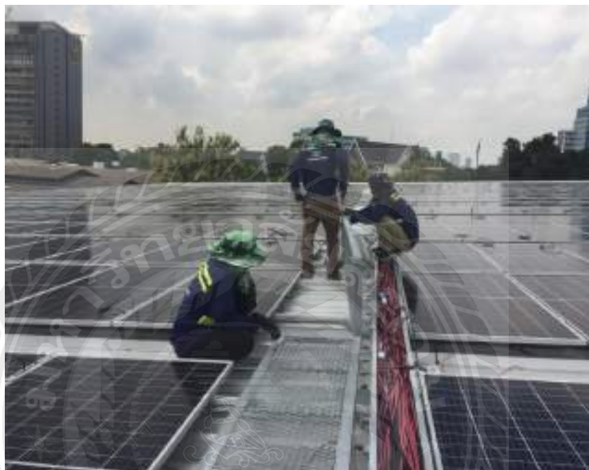
รูปที่ 4.7 ติดตั้งและเดินสายไฟ
