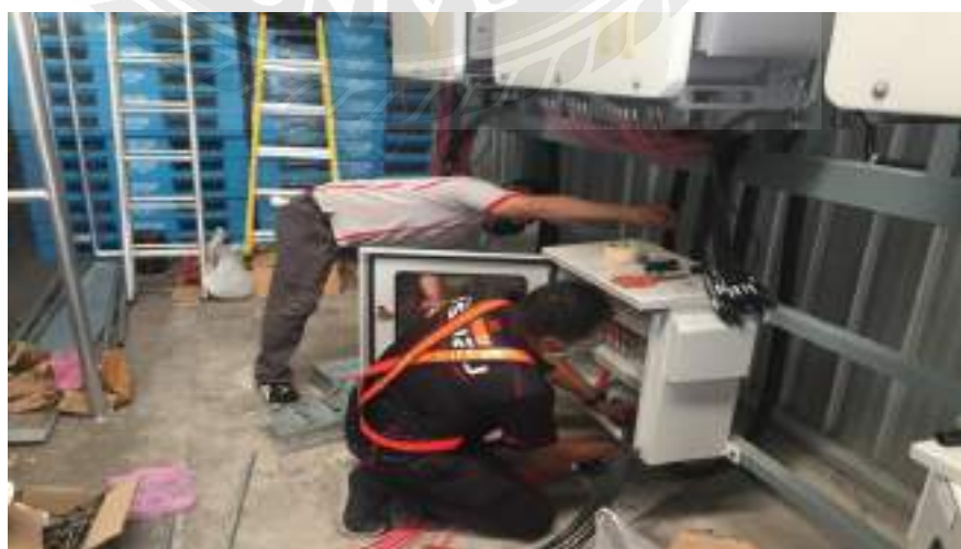
รูปที่ 4.8 ดึงร้อยสายไฟ DC เข้าตู้ควบคุม
