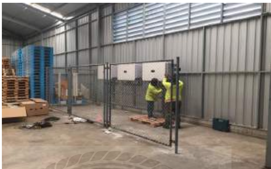
รูปที่ 4.9 ติดตั้งอินเวอร์เตอร์
