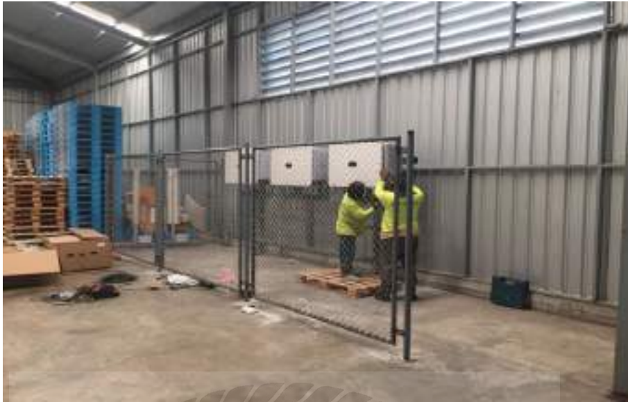
ติดตั้งอินเวอร์เตอร์
